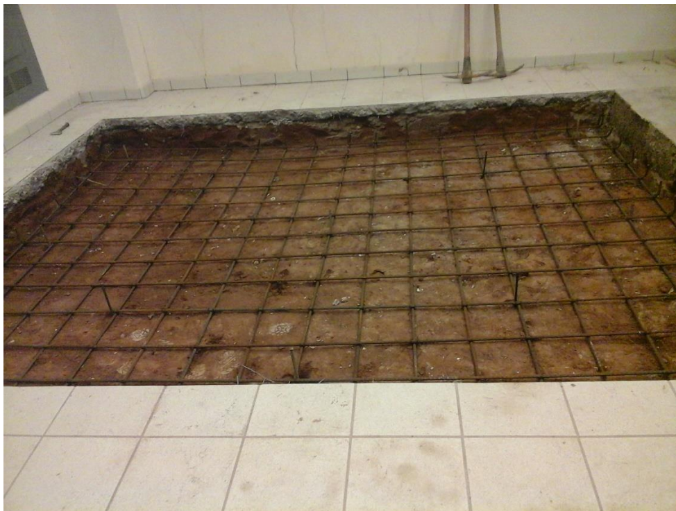
Fig. 9.- Colocado del mallado para que se acomode el cemento y soporte la carga del robot
