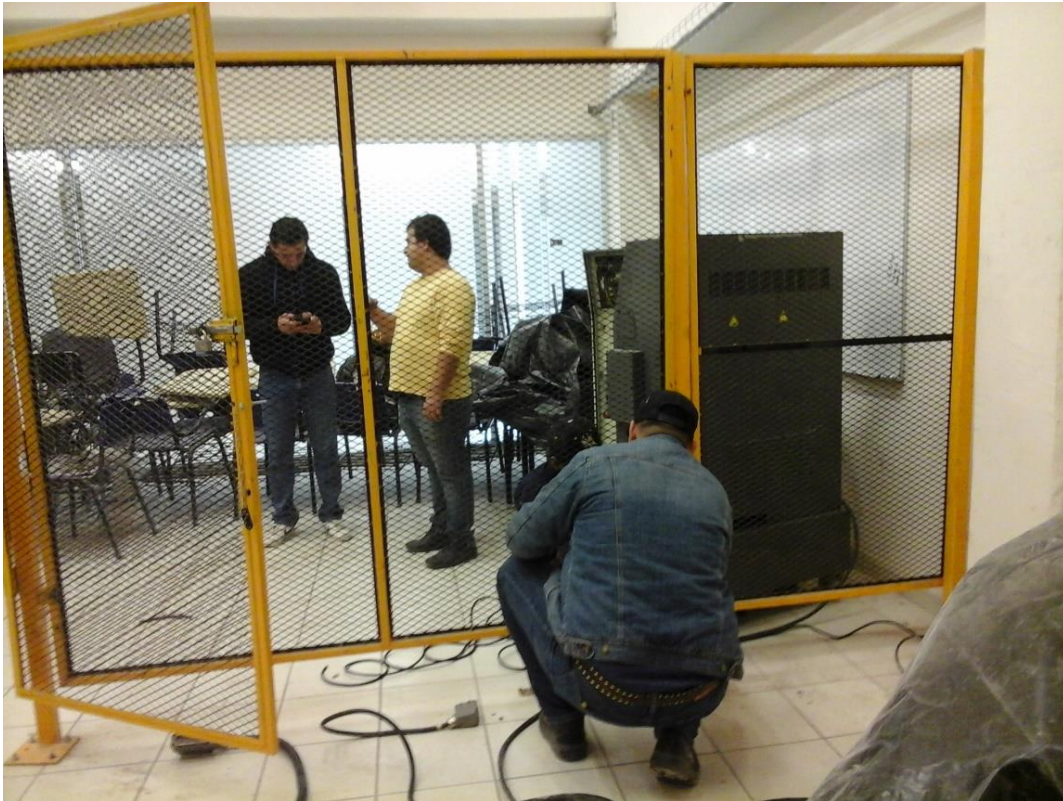
Fig. 16.- Instalación de la malla de seguridad.
