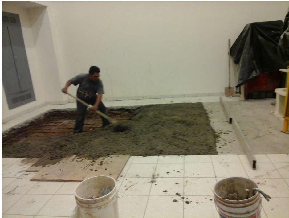
Fig. 10.- Colocado del mallado y el cemento para soporte de carga.
