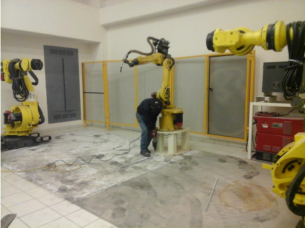
Fig. 15.- Instalación (fijación) de los robots.
