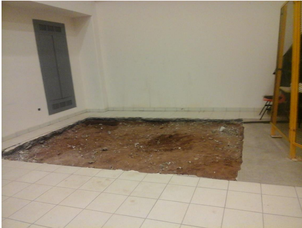
Fig. 8.- Desmantelamiento de suelo para acondicionamiento.
