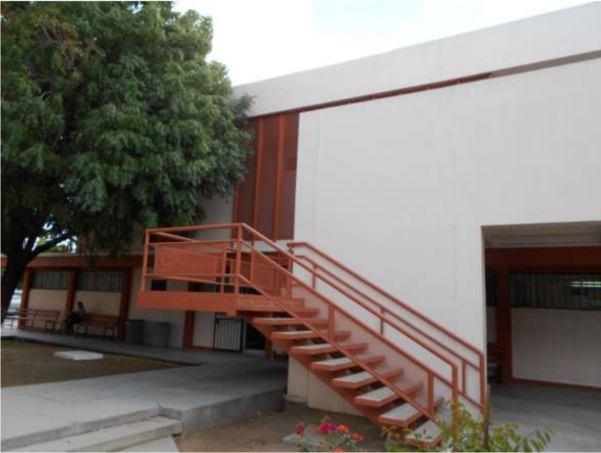
Escalera de acceso al segundo piso del bufete jurídico el cual se construyó en la remodelación que se realizó en el periodo de enero del 2017 a octubre del 2017.
