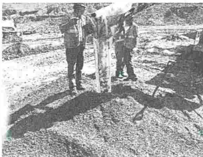
Cargado de barrenos con agua
