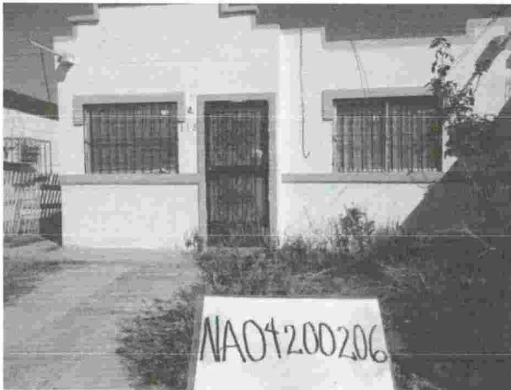
Figura 5.8 Viviendas con maleza sin cortar
