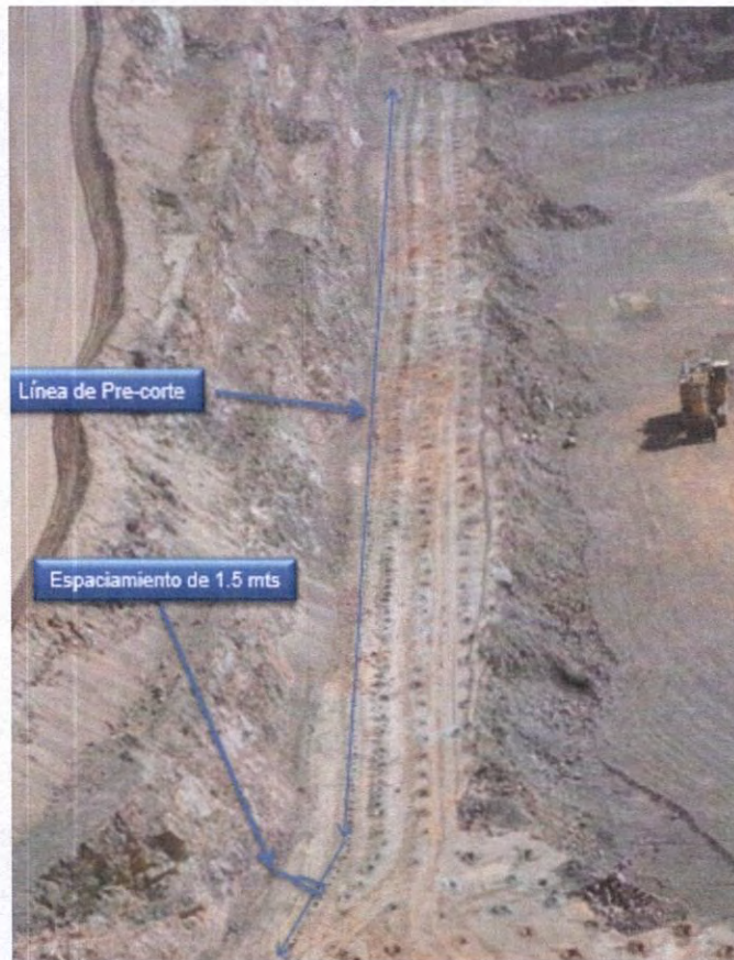
Figura 17.- Barrenación de pre corte.
