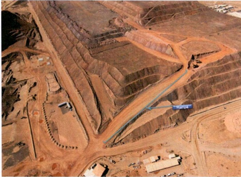
Figura 19.- Vista aérea de rampa.
