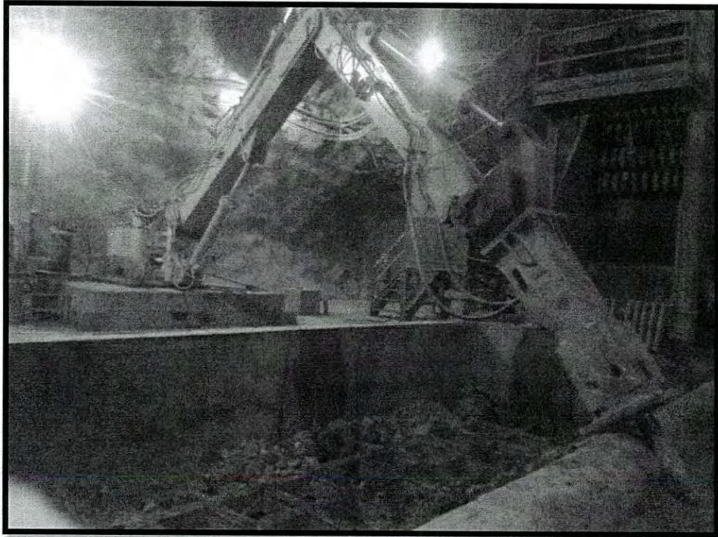
Figura 30. Parrilla con martillo hidráulico, nivel 21.
