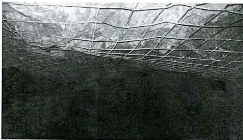
Ilustración.19.- Anclaje con malla.
