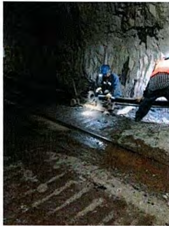
Figura 31. Se muestra la máquina de termofusión para empare de manguera de alta presión
