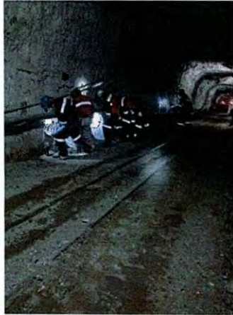
Figura 32. Con trabajo en equipo se muestra como levantan la manguera para hacerla llegar a la máquina de termofusión.
