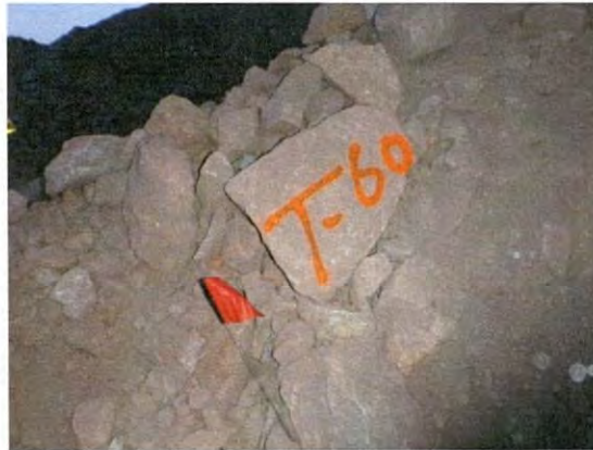
FIGURA 17. Ejemplo de marcación de terraplén.
