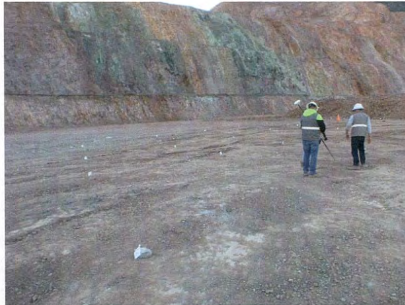
FIGURA 18. Marcación plantilla de barrenación.
