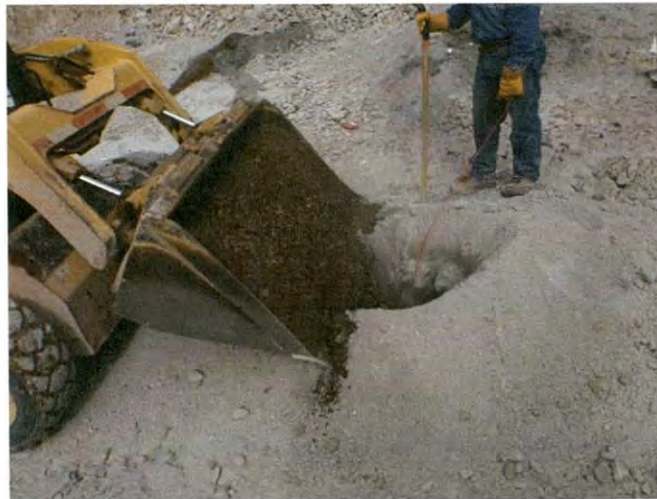
FIGURA 30. Relleno en los barrenos.
