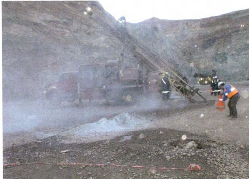
FIGURA 24. Realización de barrenos de pre corte.
