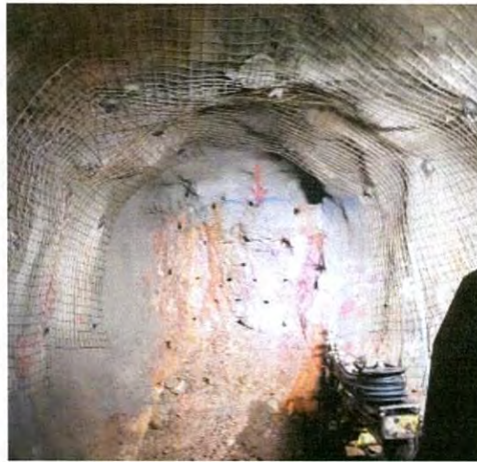
FIGURA 62. Tope enmallado con pernos de anclaje y zarpeado.
