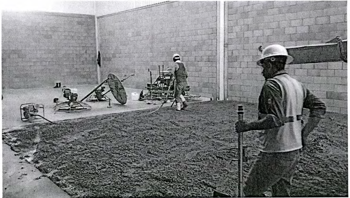
Figura A.17 Colado de Piso de Bodega
