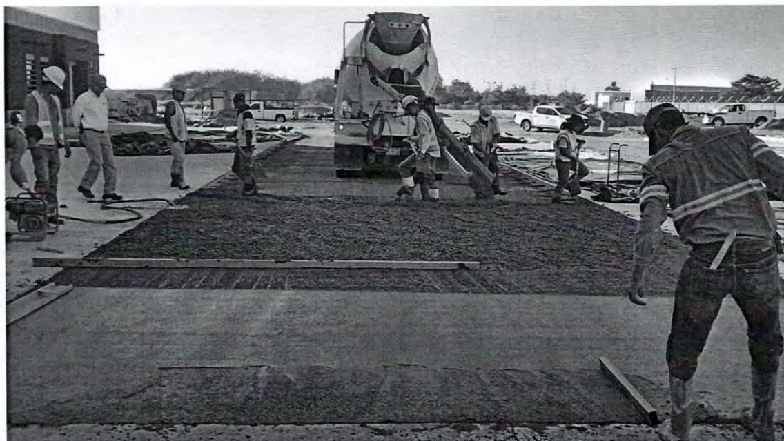
Figura 5.1.C. Colado de Parque de Maniobras
