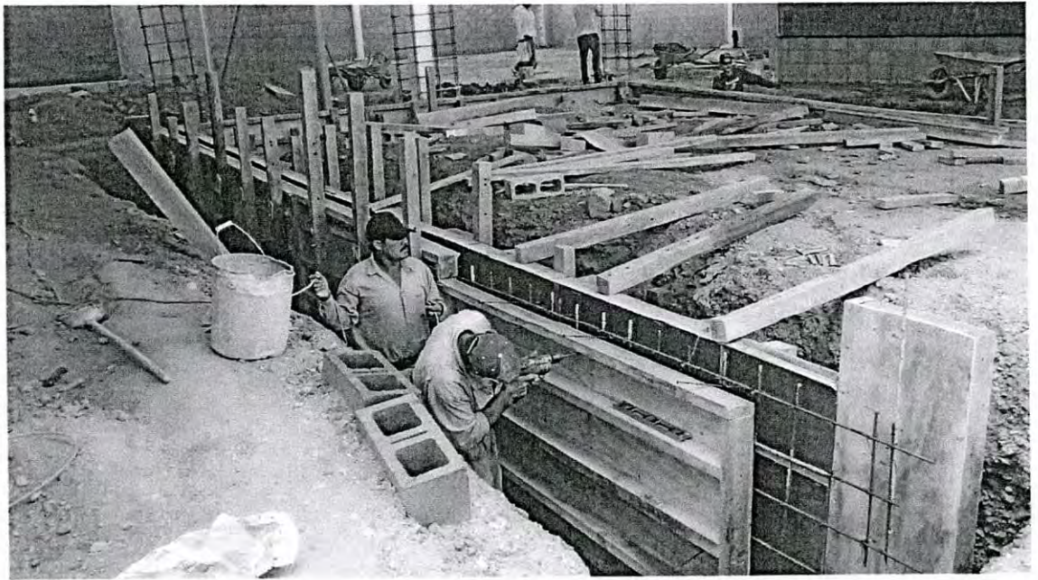
Figura A.12 Cimbra de Muro de Contención en Andén
