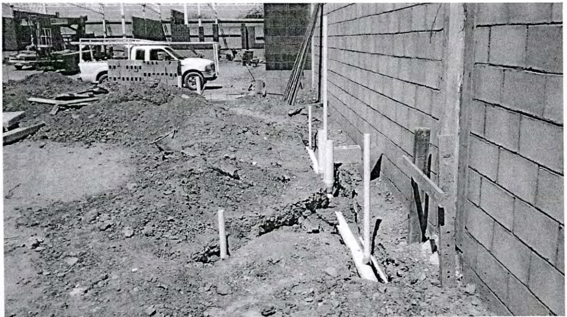
Figura A.32 Salidas Sanitarias de Baño
