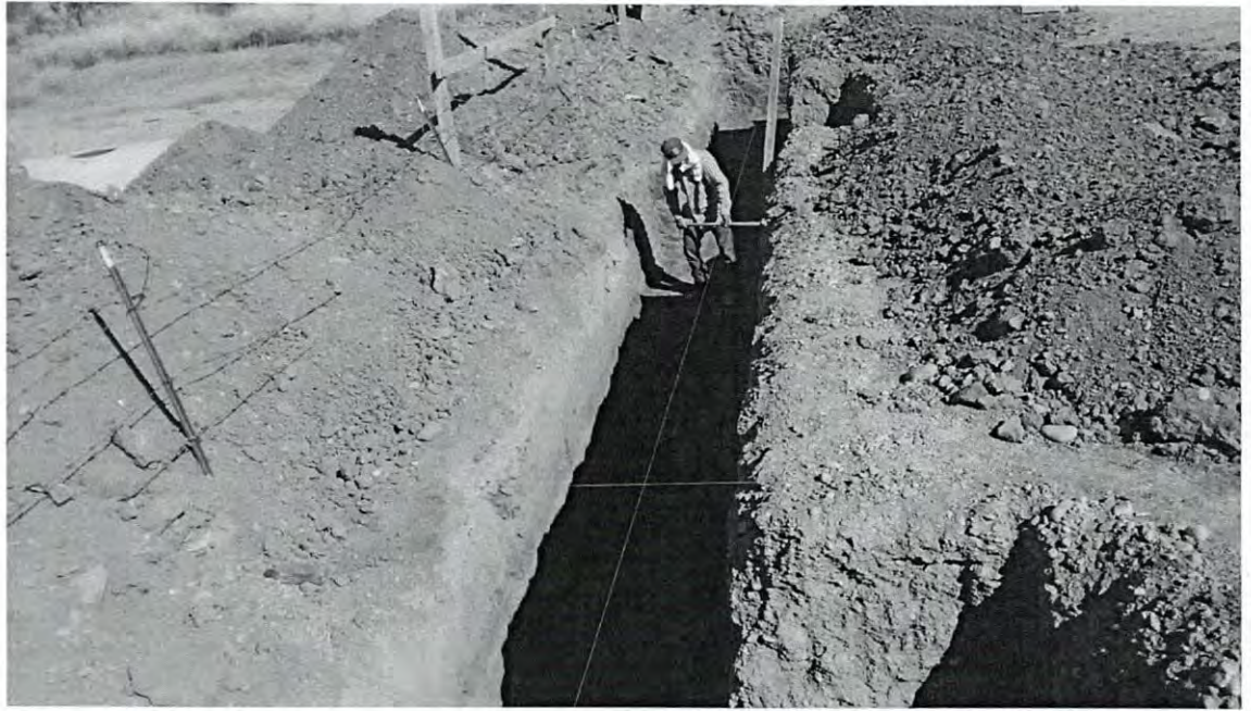
Figura 3.1.2.C. Excavación a Mano
