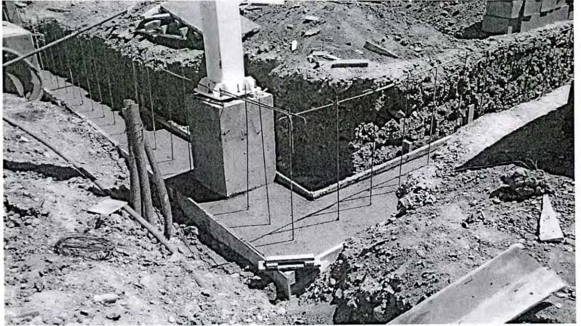
Figura A.3 Colado de Zapata Corrida
