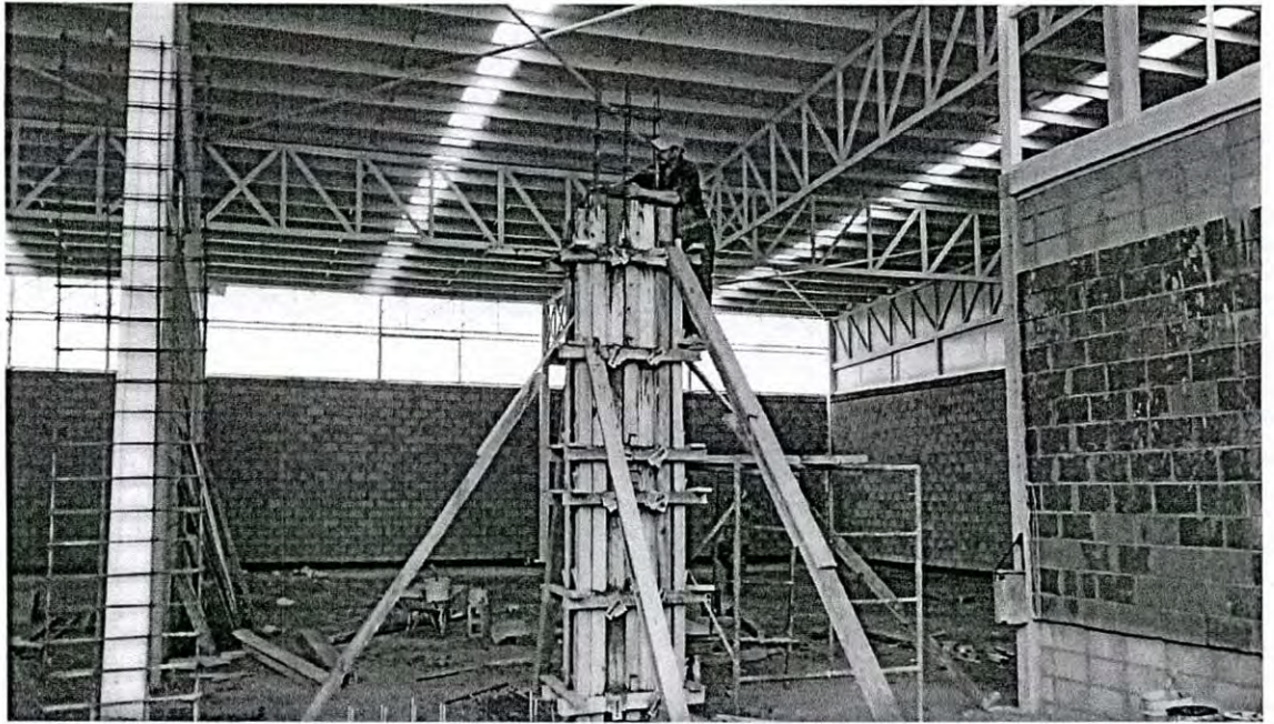
Figura A.13 Cimbra en Columna de Andén
