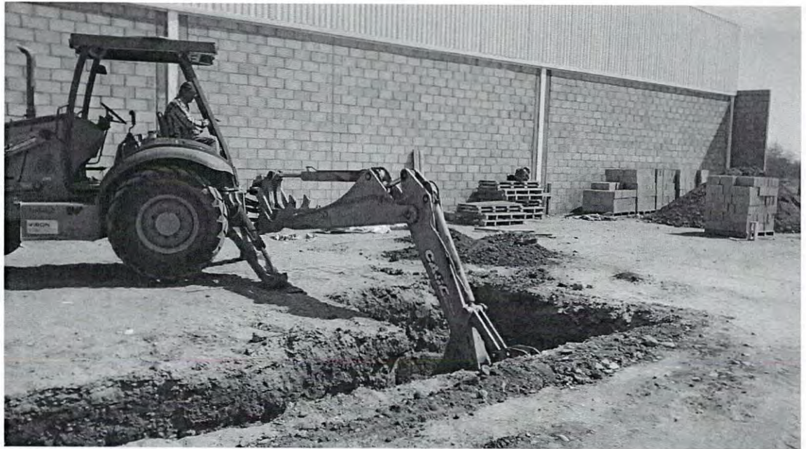
Figura 3.1.1.B. Excavación con Retroexcavadora
