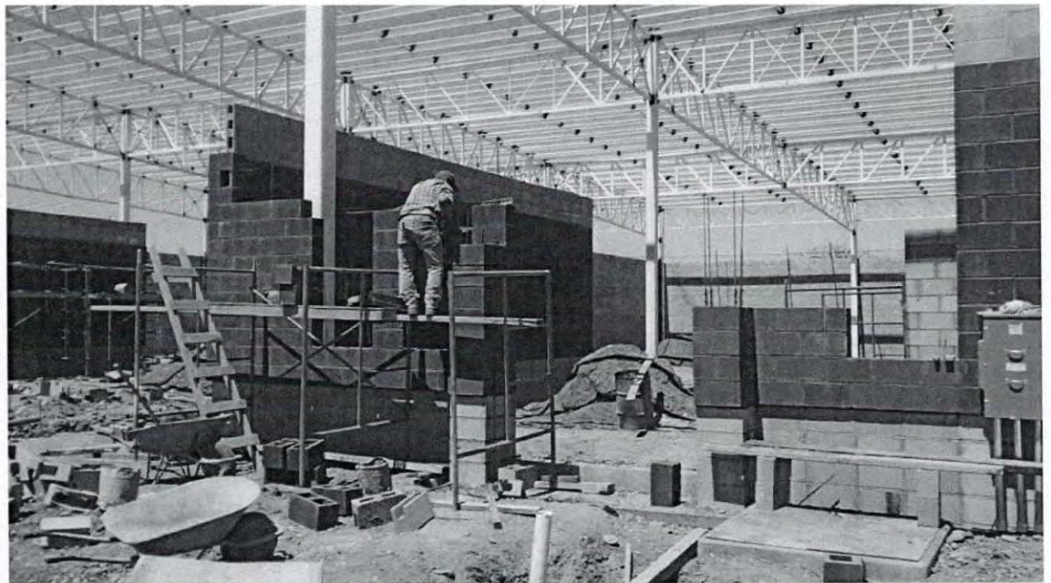
Figura 3.4.1.B. Colocación de Block Negro
