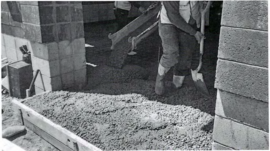
Figura 2.1.i. Escalón en Puerta Principal de Bodega
