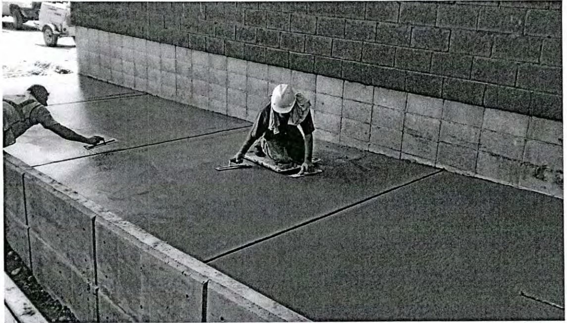
Figura A.35 Rampa dejándola lista para el Acabado Escobillado
