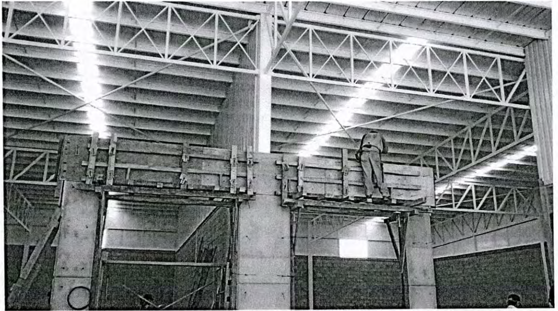
Figura A.14 Cimbra de Viga en Área de Andén
