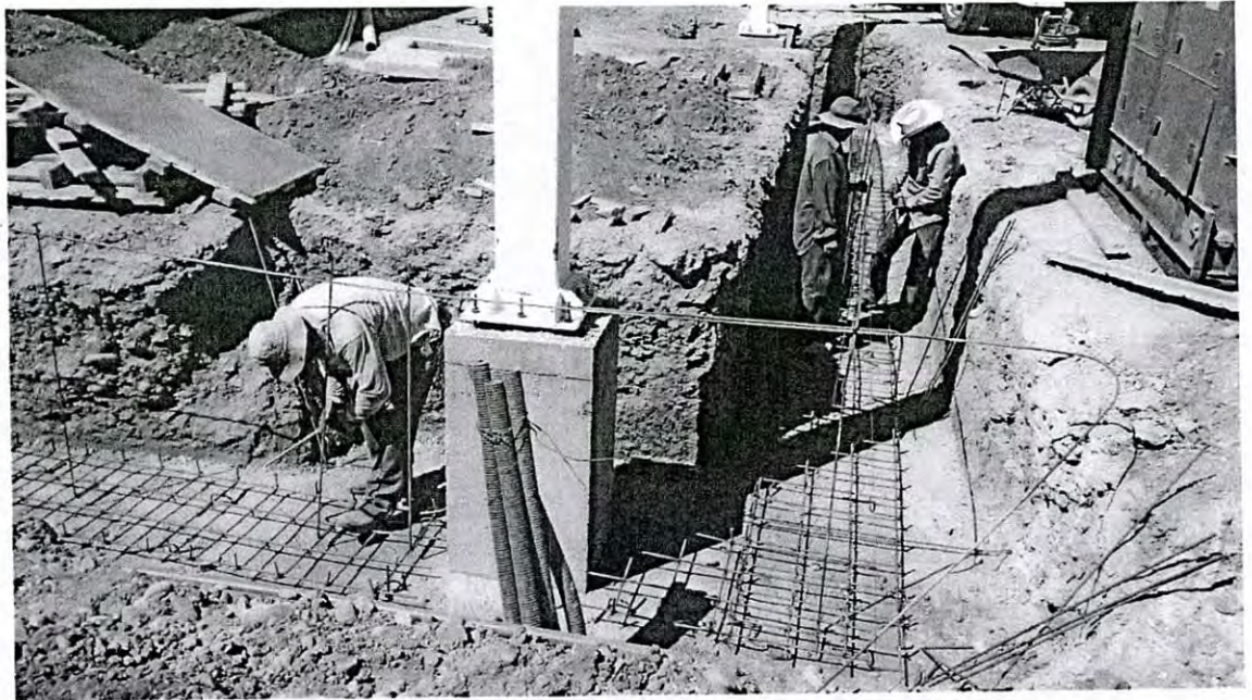
Figura A.2 Armado de Zapata Corrida
