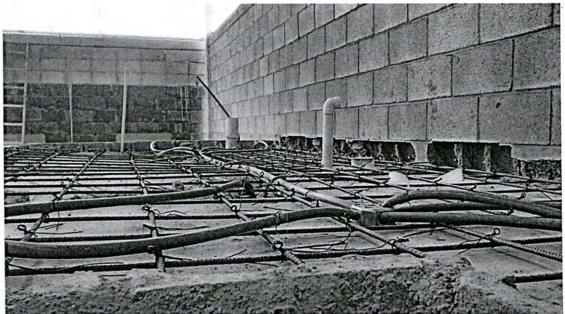
Figura A.30 Sembrado Eléctrico en Losa de baño
