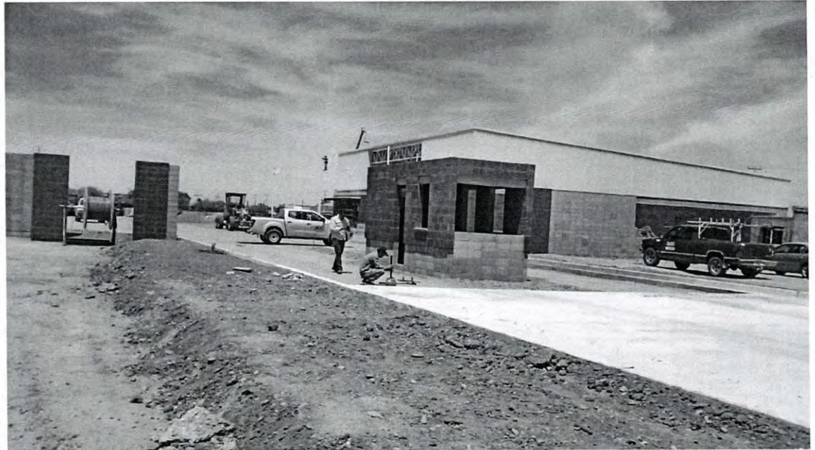
Figura 1.2 Caseta y Parque de Maniobras en un 75%
