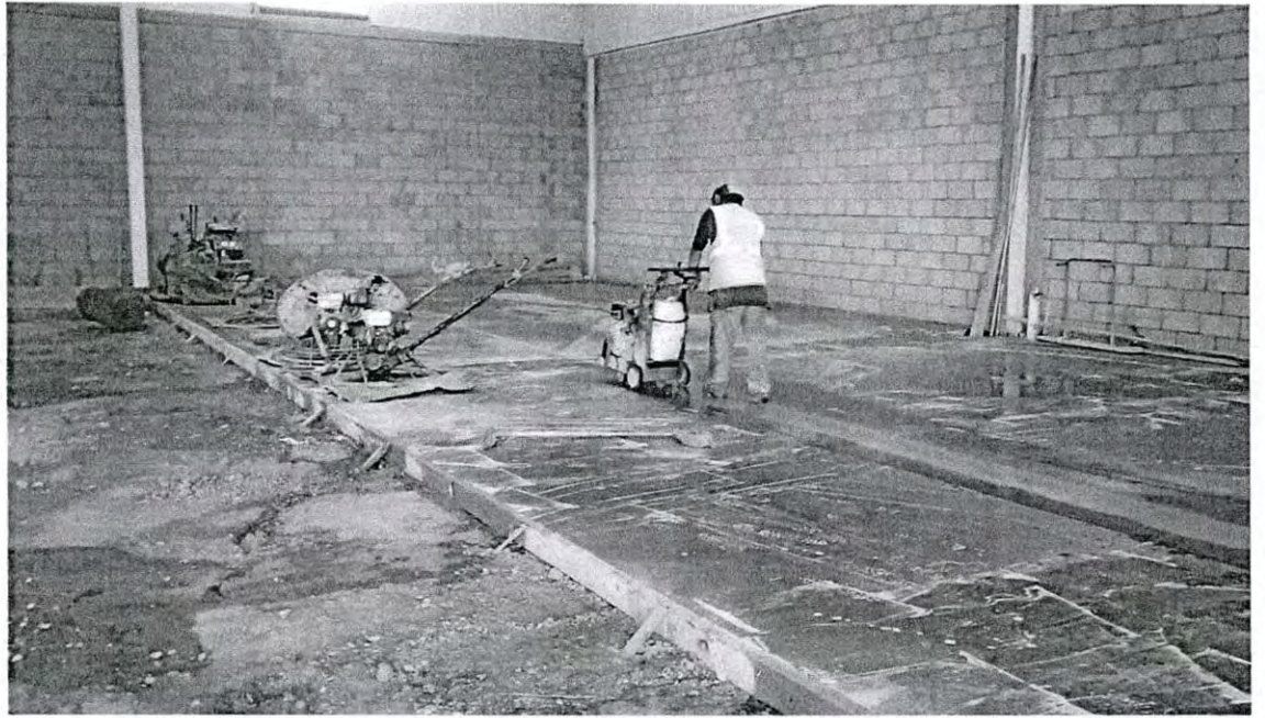
Figura A.19 Corte con Sierra para el Calafateo
