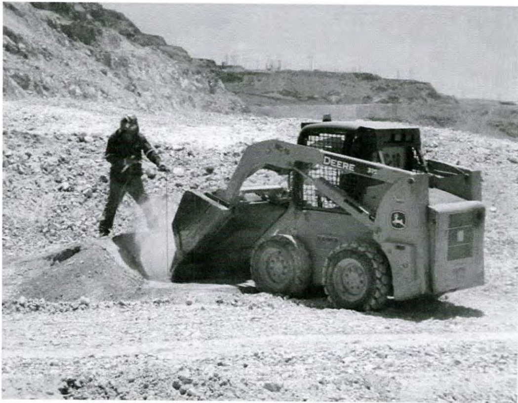
Figura 11. Tapando barrenos
