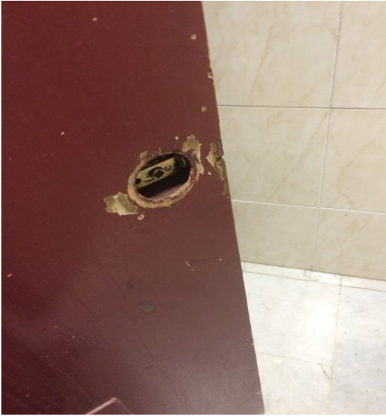
Figura 10. Puerta del baño de hombres
