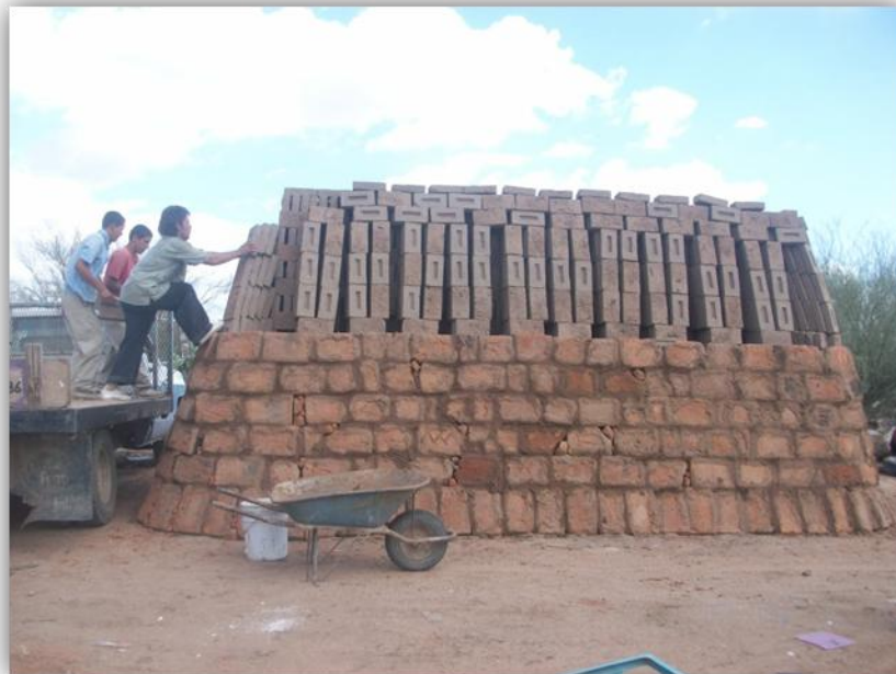
Figura 4.- Armado del horno
