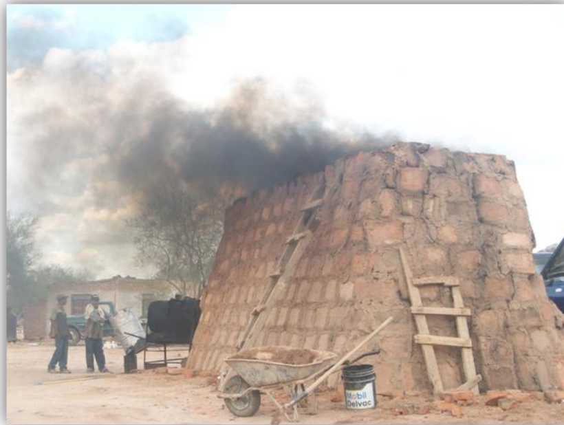
Figura 5.- Cocción del ladrillo
