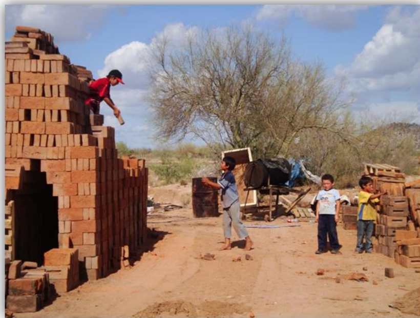
Figura 6.- Desmontado del Horno
