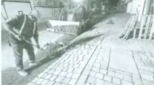
Trabajos realizados por la calle Serdán en beneficio supuestamente de los discapacitados.
