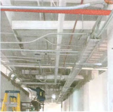
CANALIZACION Y ESCALERILLA SECCION 002
