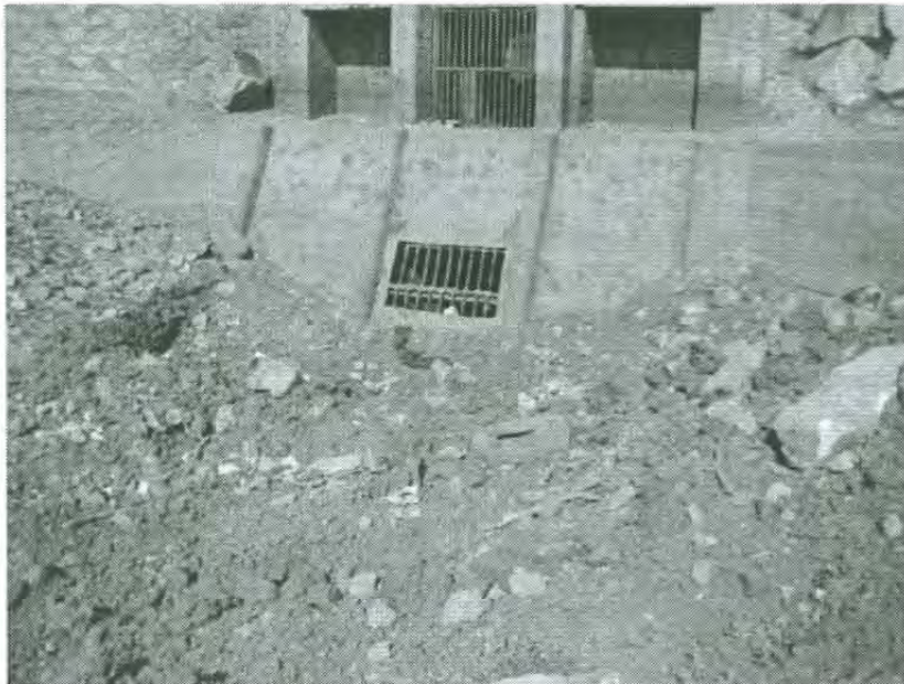
Figura 6. Condiciones Actuales de la Zona Compuerta, Localizada en la Presa Abelardo L. Rodríguez.
