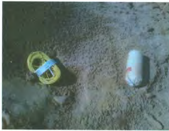
Figura 6. Fotografía de retardador y emulsión utilizada en voladuras
