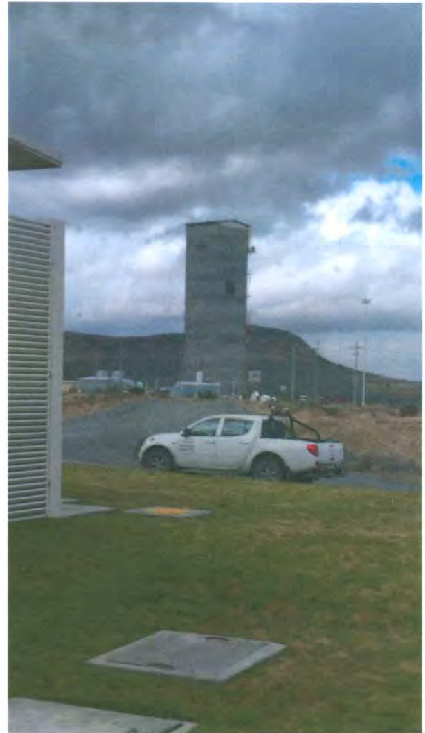
Figura 11. Fotografía del Tiro Jarillas.
