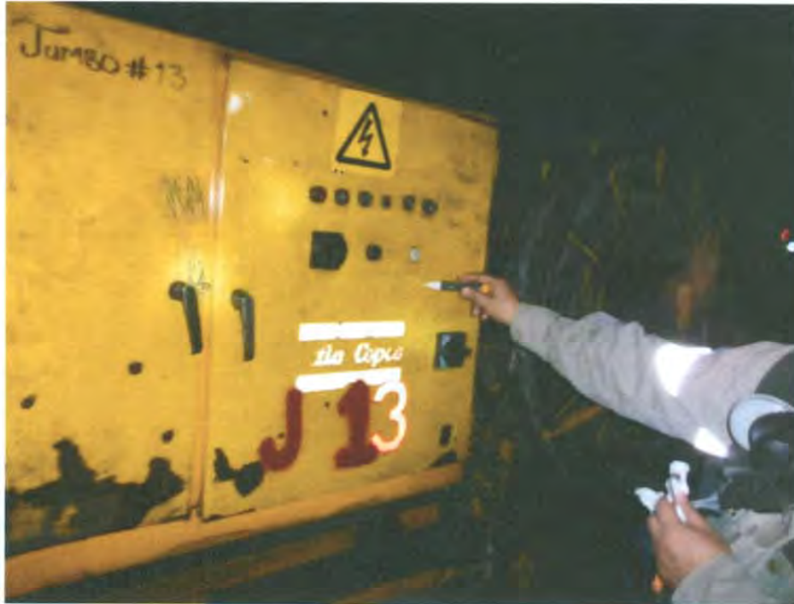
Figura 3. Inspección con el Angelito para revisar posible cargas eléctricas.
