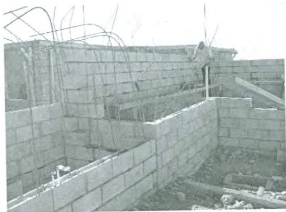
4.- Levantamiento de muros.
