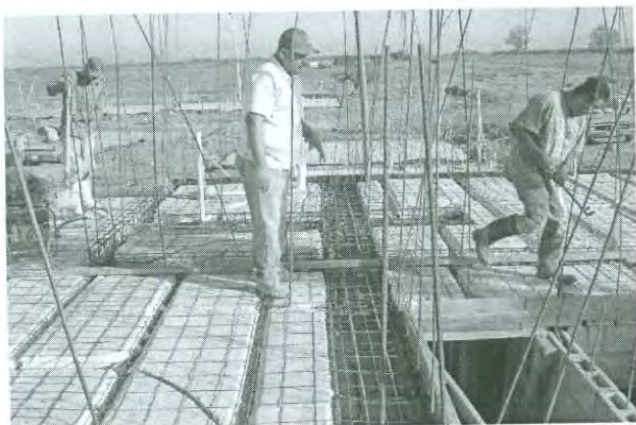
5.- Colocación de acero en losas .
