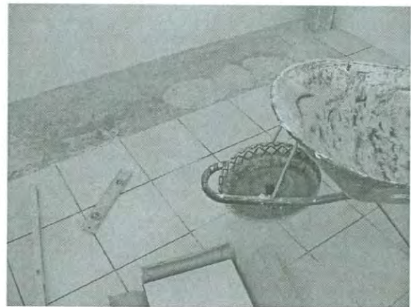
10.- Colocación de vitropiso.
