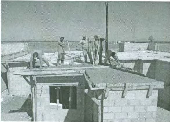
7.-Colado de losa de azotea.
