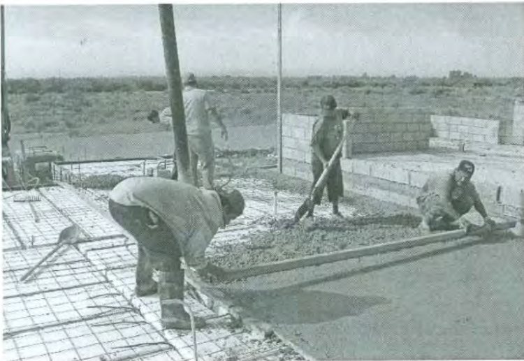
Figura 33.- Proceso constructivo de losa de azotea
