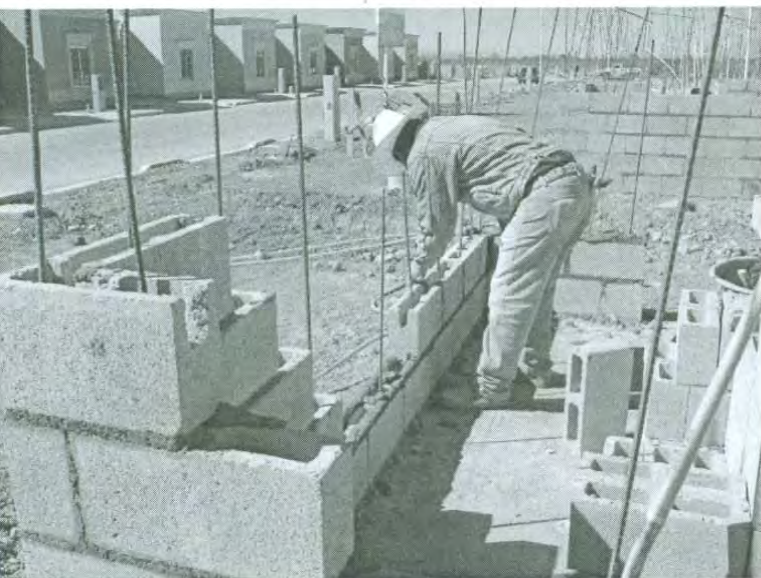
Figura 28.- Detalle de armado de castillos y cerramientos.
