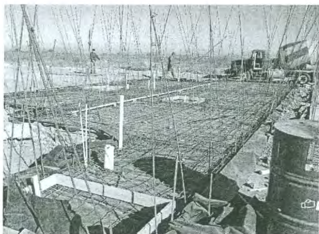
Figura 25. Acero de cimentación
