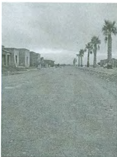
11.- Preparación para pavimentación
