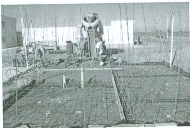
3.- Colado de cimentación.
