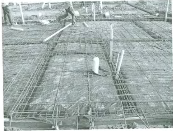
2.- Acero de cimentación.
