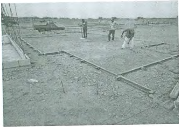
1. Cimbra de cimentación.
