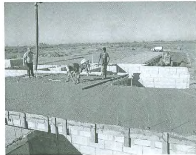
Figura 33.- Proceso constructivo de losa de azotea
