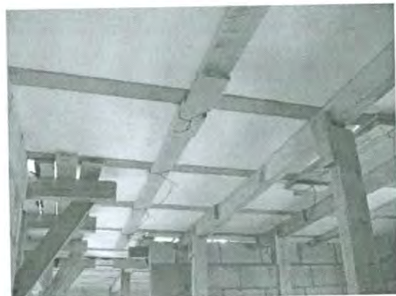
6.- Cimbra de losas.
