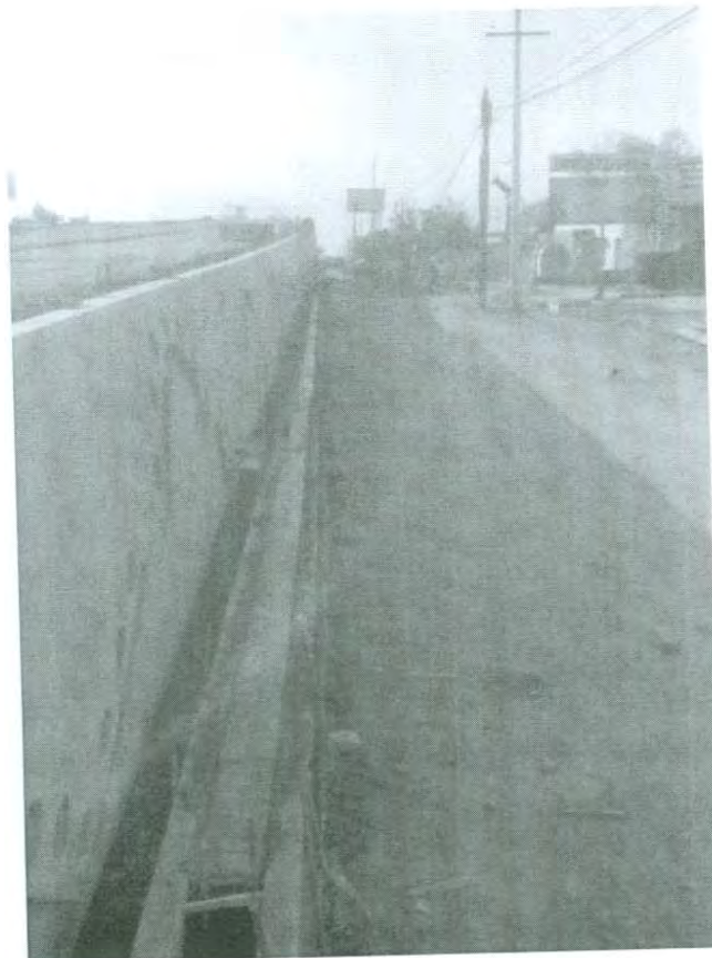
ALINEACION DE GUARNICIONES, EN BLVD QUIROGA Y GARCIA MORALES.
