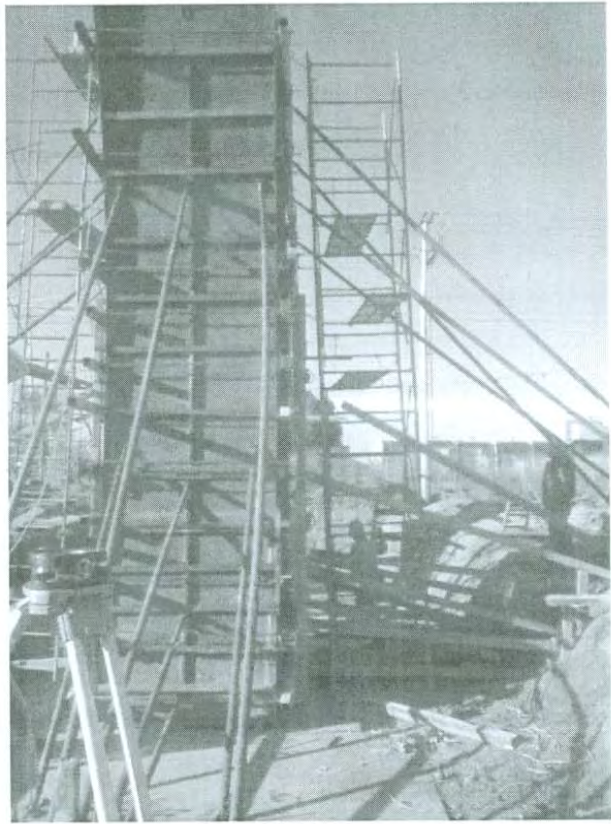
ALINEACION DE COLUMNAS DE SOPORTE PARA BALLENAS, EN PUENTE BLVD QUIROGA Y GARCIA MORALES.
