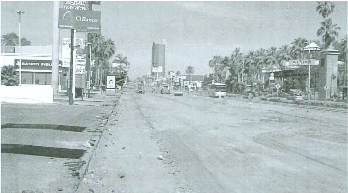
TRATAMIENTO Y NIVELACION TE TERRENO. BLVD EUSEBIO KINO, HERMOSILLO, SONORA.
