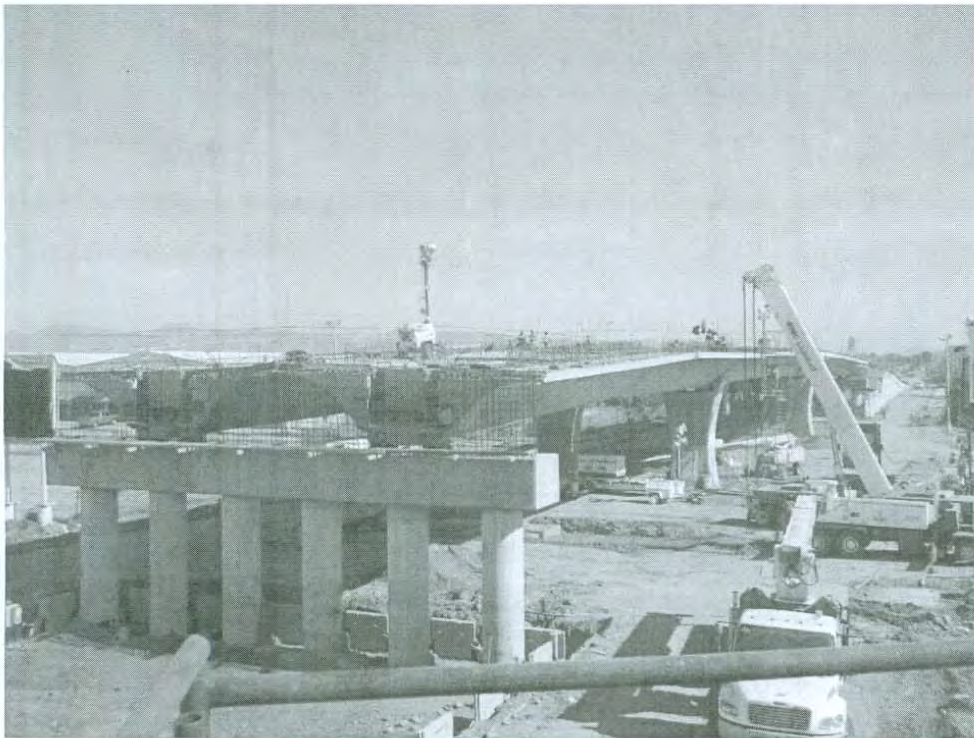
MONTAJE DE VIGAS “BALLENAS”, EN BLVD QUIROGA Y GARCIA MORALES.
