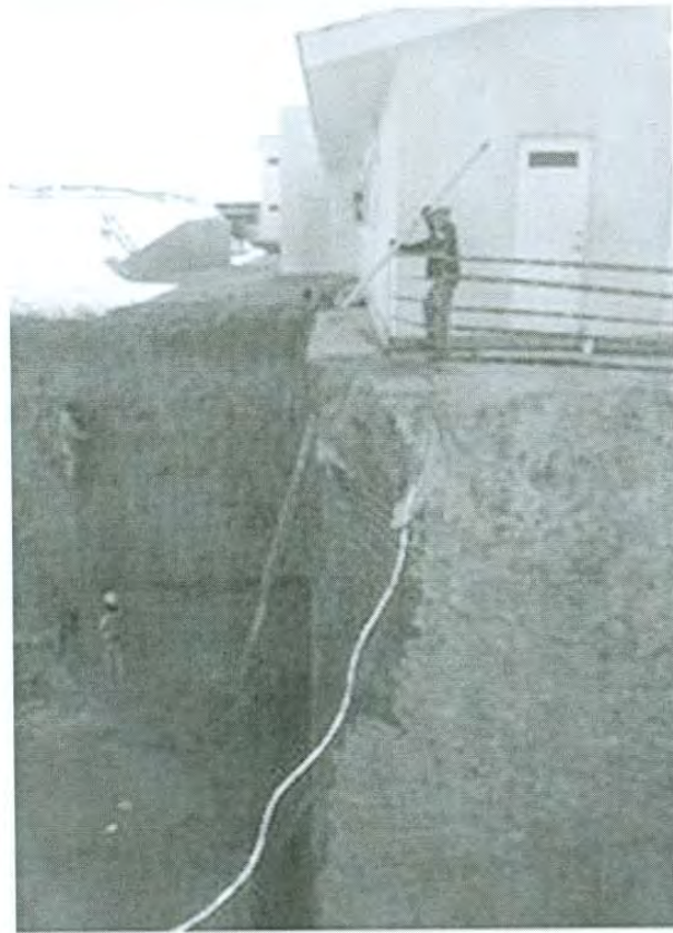
NIVELES PARA RAMPA EN HELIPUERTO, EN POLICIA FEDERAL PREVENTIVA PFP.
