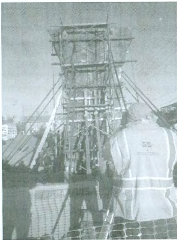
ALINEACION DE COLUMNAS DE SOPORTE PARA BALLENAS, EN PUENTE BLVD QUIROGA Y GARCIA MORALES.
