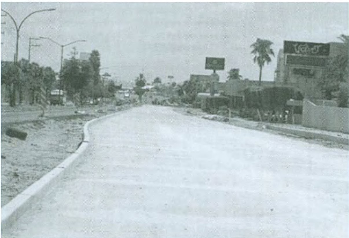
PAVIMENTACION, CONCRETO HIDRAULICO. BLVD. EUSEBIO KINO, HERMOSILLO, SONORA.
