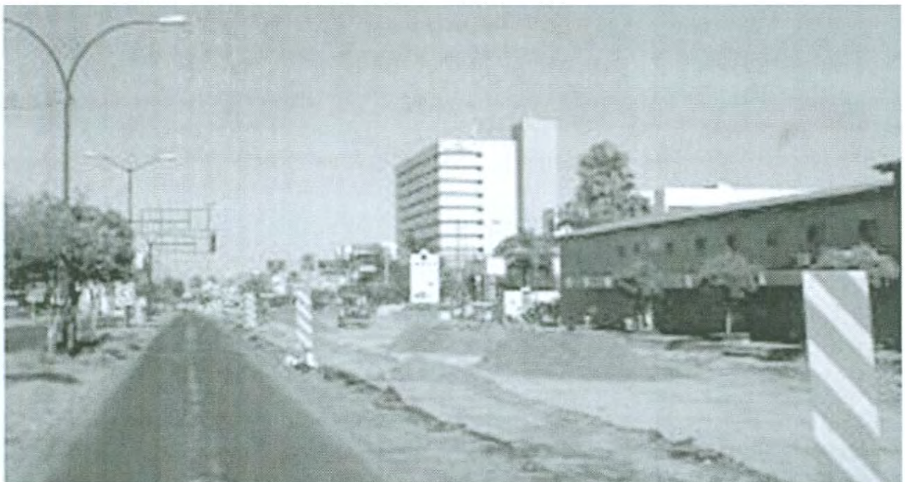
SUMINISTRO DE MATERIAL DE RELLENO EN BLVD. EUSEBIO KINO. HERMOSILLO, SONORA.
