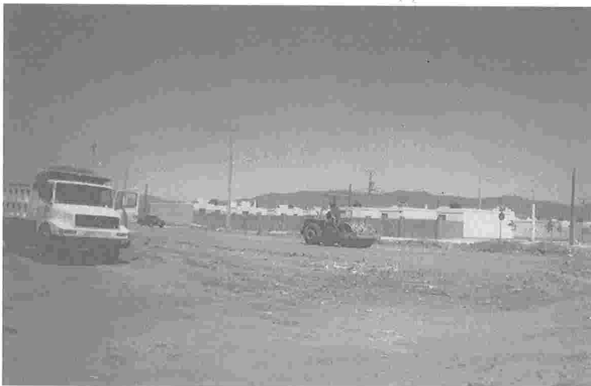
Foto #1. Compactación de plataforma.
