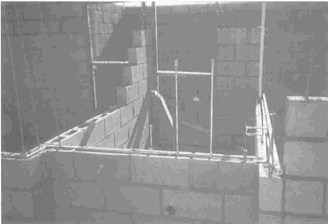
Foto #7. Instalación hidráulica y de gas en muro.
