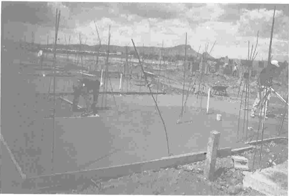
Foto #4. Colado de losa de cimentación.
