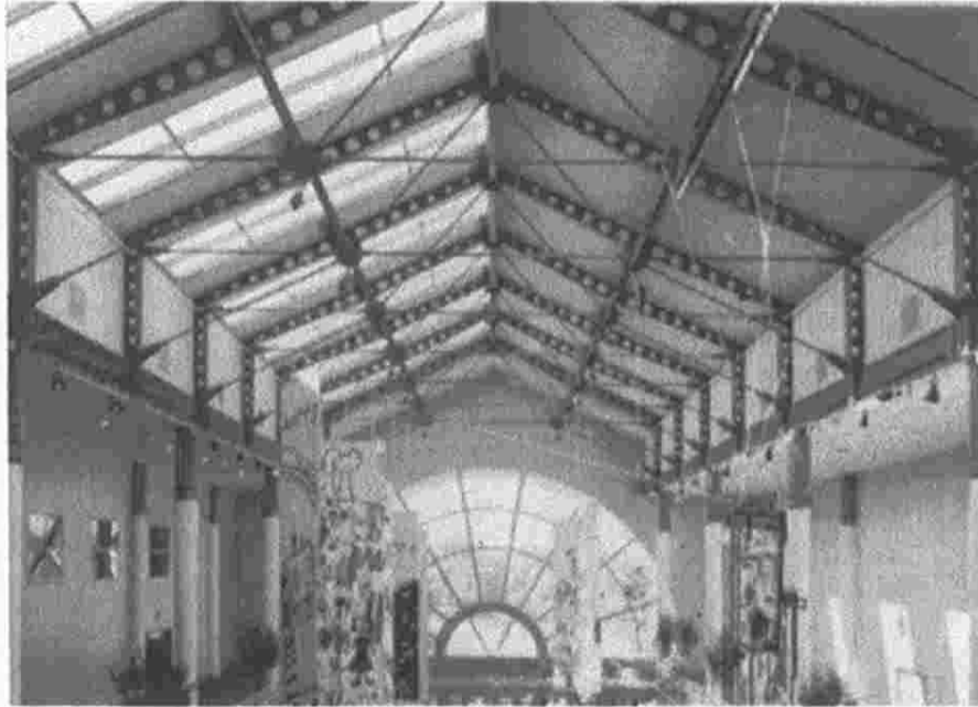
Figura 2.2 Perfiles con almas agujeradas
