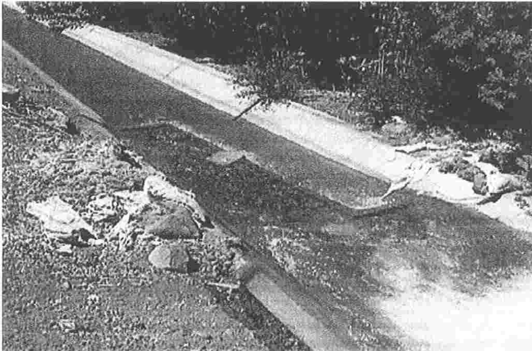
Foto 3.2.1. Represa Pico de pato en operación.
