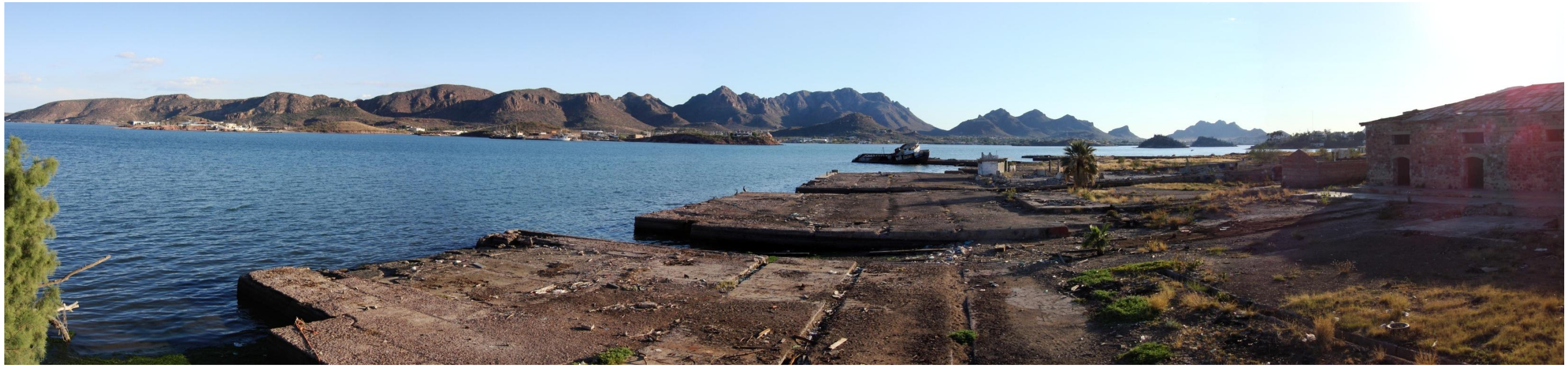
IMAGEN 44: Vista general del predio y paisaje. Fotografía: Juan Luis Fernández V.
