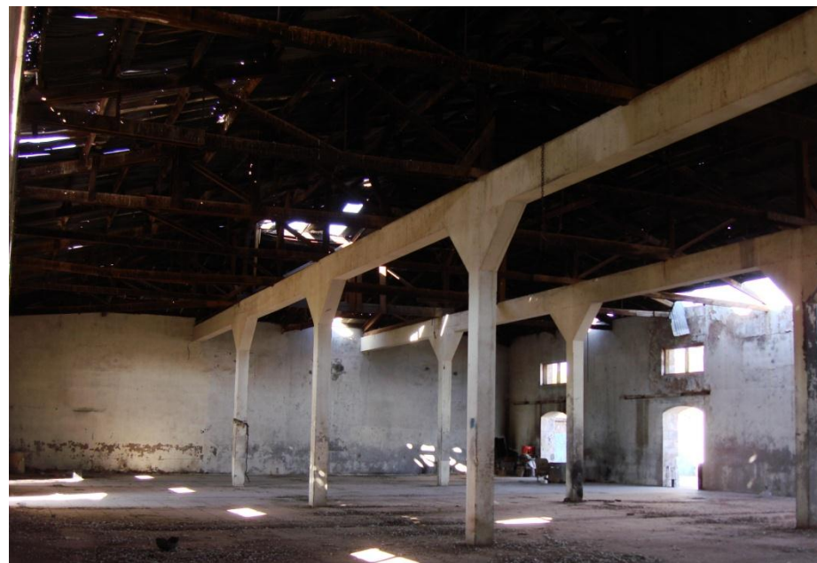
IMAGEN 39: Interior actual edificio del antiguo rastro. Fotografía: Juan Luis Fernández V.
