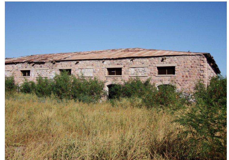
IMAGEN 35: Estado actual del edificio del antiguo rastro vista poniente. Fotografía: Juan Luis Fernández V.
