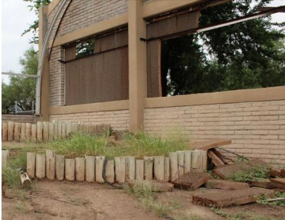
Fotografía 12. Paneles inutilizables a causa de las lluvias de la temporada.
