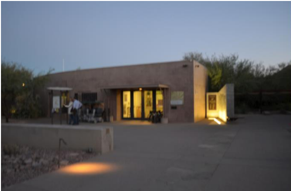
Fotografía 24. Edificio de concreto.
