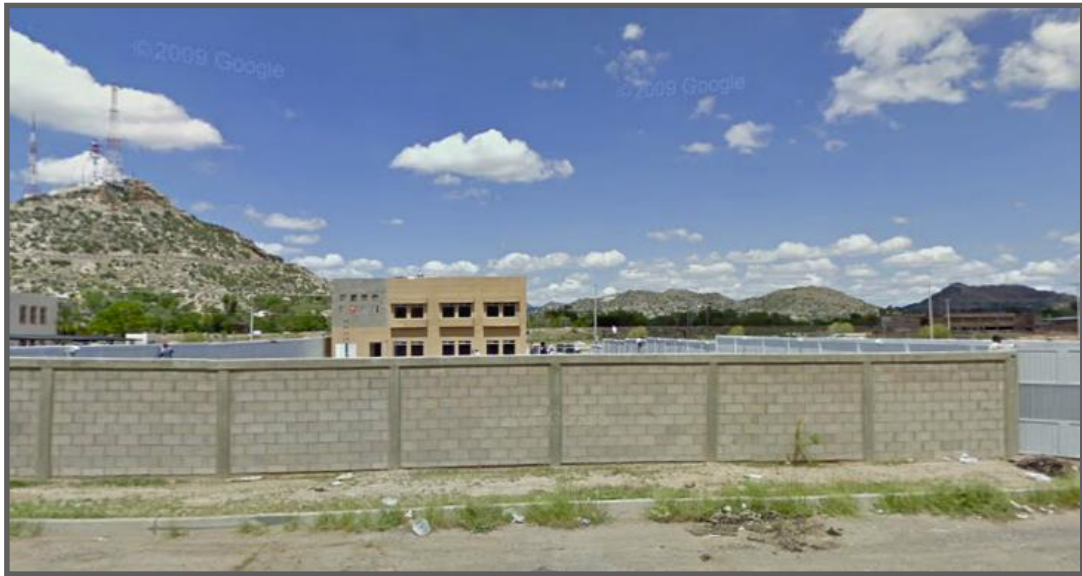
Fotografía 5. Edificio del PAN se encuentra enfrente del terreno por el Blvd. Cultura Fuente: Google Street View
