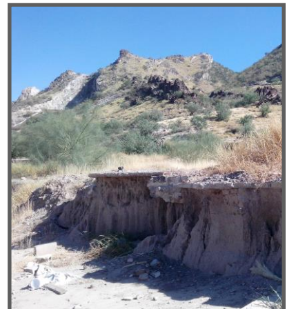
Fotografía 13. Vista Firme Concreto. Fuente: Archivo Propio
