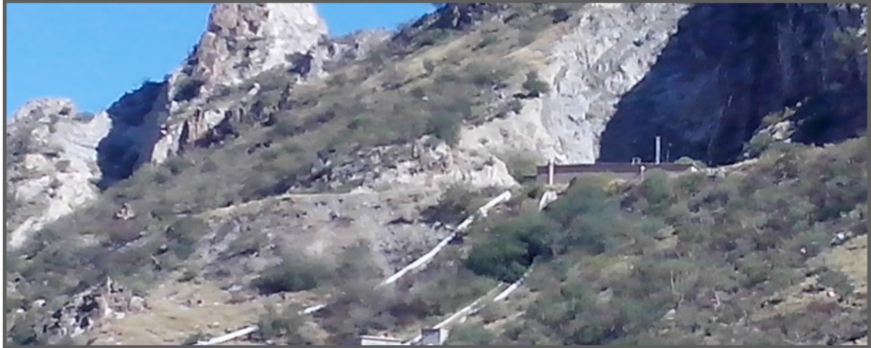
Fotografía 10. Vista Tanque Elevado desde terreno. Fuente: Archivo Propio
