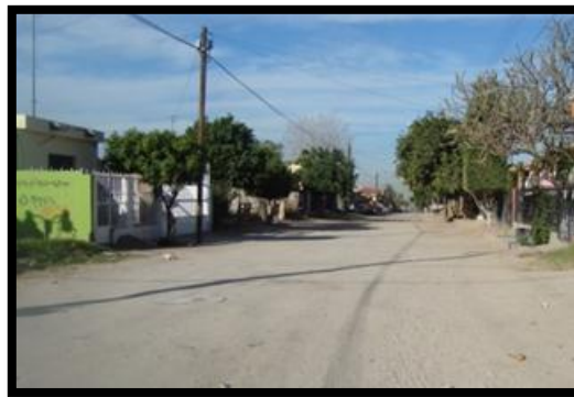
Foto. 1.19. Fotografía que muestra una de las vialidades de tierra, debido a su uso. Fuente: Liliana Rios Valenzuela - Septiembre 2011.
