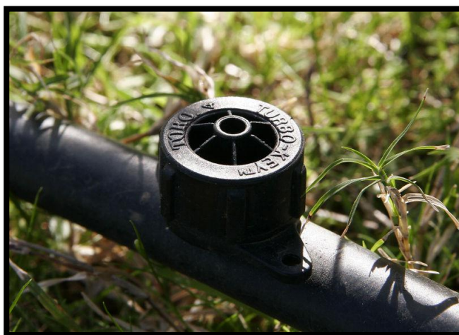
Fig. 2.4. Fotografía que muestra la tubería empleada para el riego por goteo.
