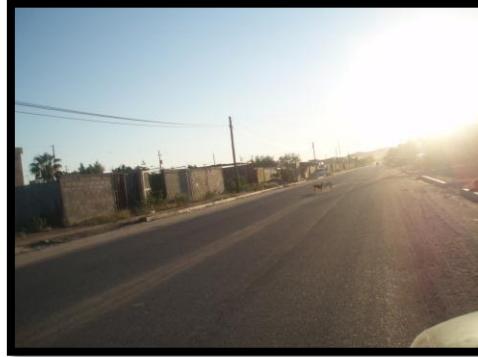
Foto. 1.18. Fotografía que muestra una de las vialidades con mejor pavimentación. Fuente: Liliana Rios Valenzuela - Septiembre 2011.
