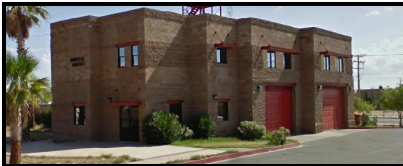
Foto. 1.16. Fotografía que muestra la Estación de Bomberos Norte de la ciudad de Hermosillo.
