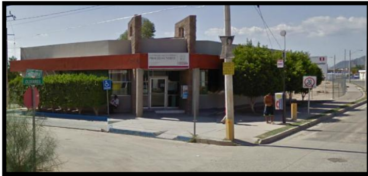
Foto. 1.15. Fotografía que muestra uno de los módulos del IMSS del sector.
