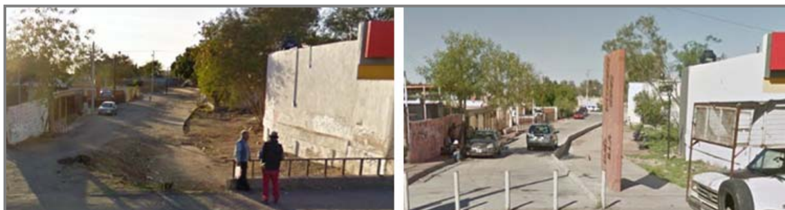
Imagen 2-1. Canal existente en septiembre 2009 y canal embovedado junio 2010
