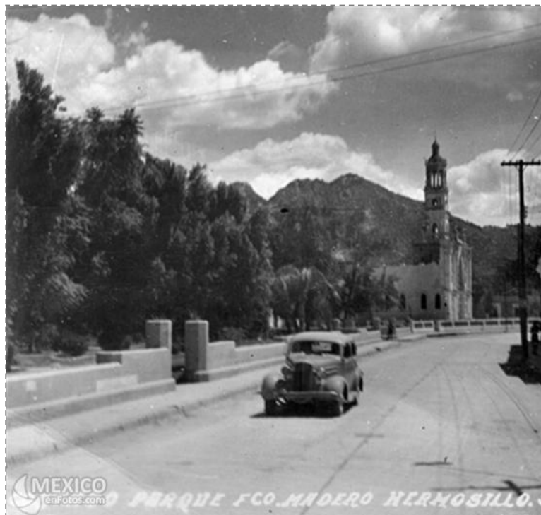
Imagen del acceso al Parque Madero
