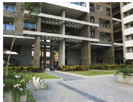
Fotografía 2. 2 Área común de
