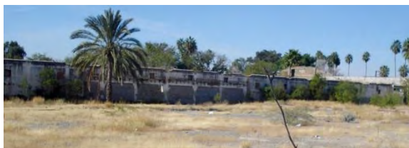
Fotografía 1. 2 Vista 1 del terreno, Fuente: propia.
