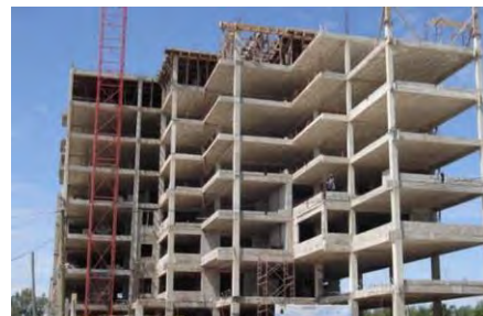
Fotografía 2. 4 Edificio en obra. Fuente: skyscrapercity
