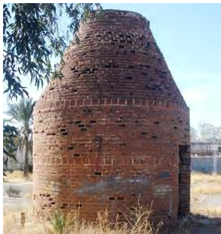
Fotografía 1. 6 Construcción en el predio. Fuente: Propia.
