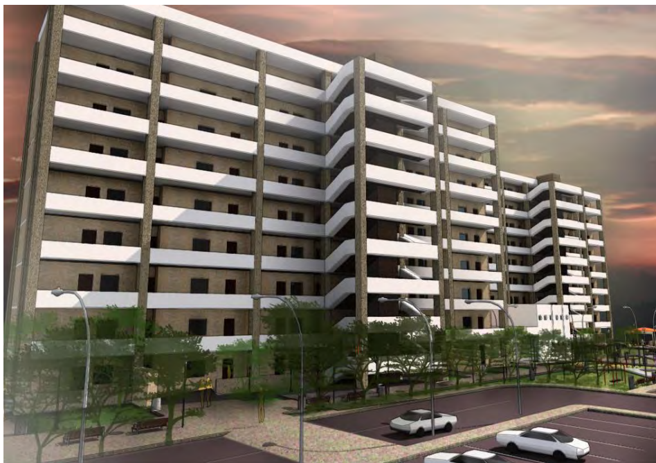
Imagen 2. 15 Vista exterior desde el acceso
