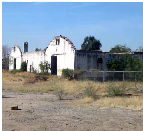
Fotografía 1. 7 Construcción abandonada fuera del predio. Fuente: Propia.
