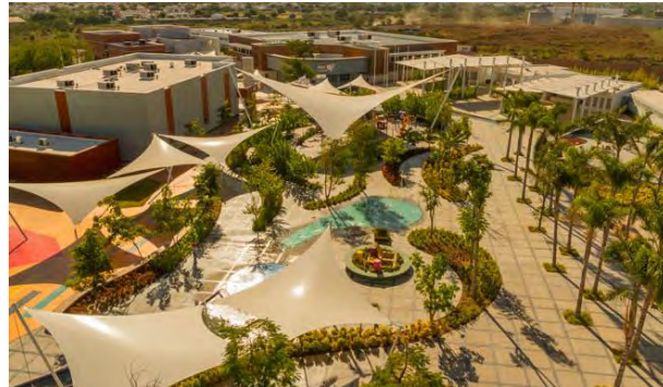
Imagen 35. Acabados aparentes. Fuente: Obra del año, 2017.
