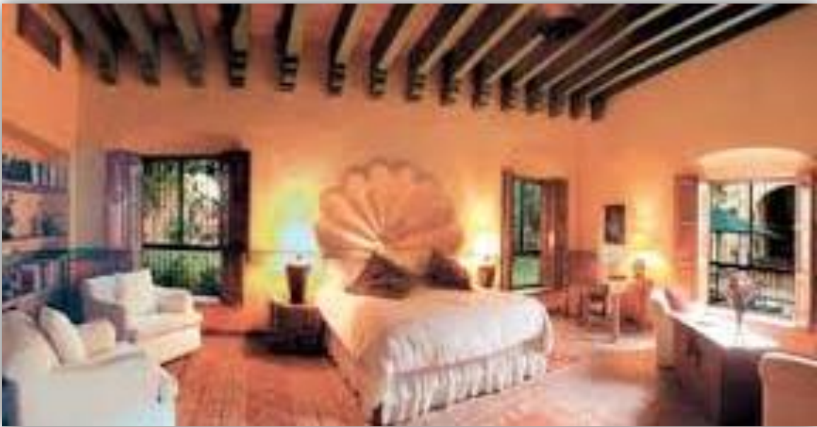
Ilustración 6 Vista interior de las habitaciones, donde se puede observar a simple vista el sistema de techumbre que se utiliza (vigas de madera).
