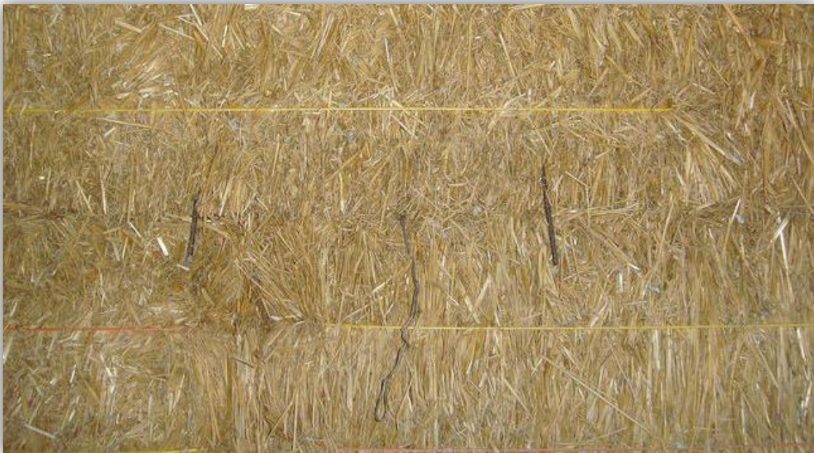
Ilustración 11. Vista del recubrimiento interior de paja en una de las habitaciones del hotel Boutique Econatura. Fuente: http://www.hoteleconatura.com/
