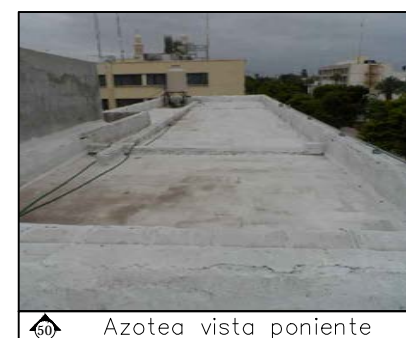
50 Azotea vista poniente
