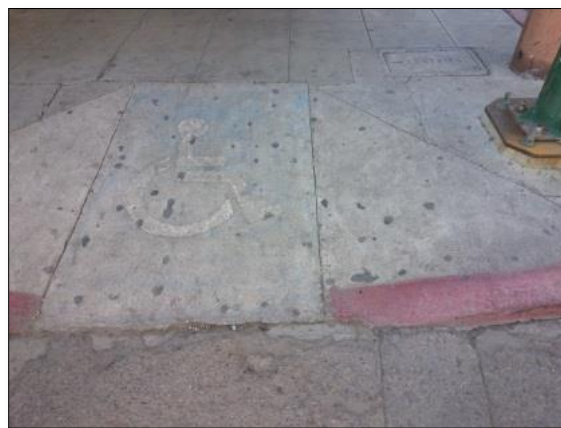
Imagen 21 Rampa de discapacitados
