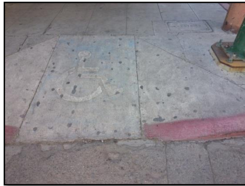
Imagen 76 Rampa existente en el predio (Barragán 2014)
