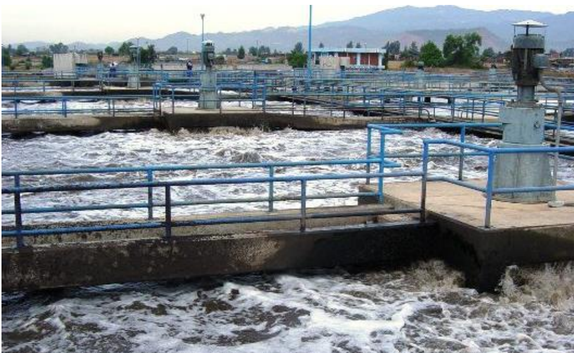
Imagen 2.1 Planta tratadora de aguas residuales. Fuente: Google.
