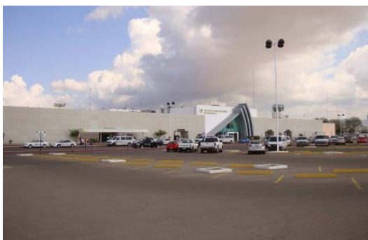
Imagen 2.10 Aeropuerto Internacional de Hermosillo Sonora, Fuente: Autoría Propia.
