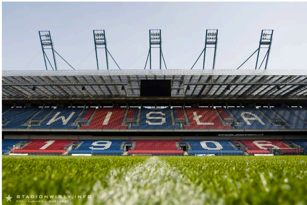
2.22 Detalle de Iluminación de Estadio Henryk Reyman, Fuente: Piotr Drabik.
