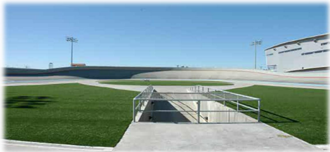
Ilustración 28. Velódromo con empastado sintético y firme de concreto
