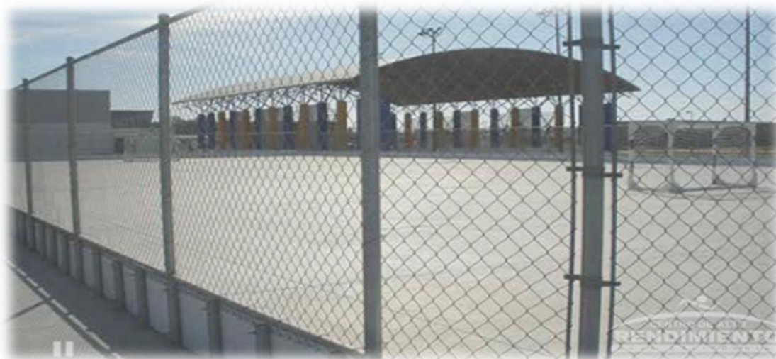
Ilustración 18. Cancha de Hockey a base de concreto
