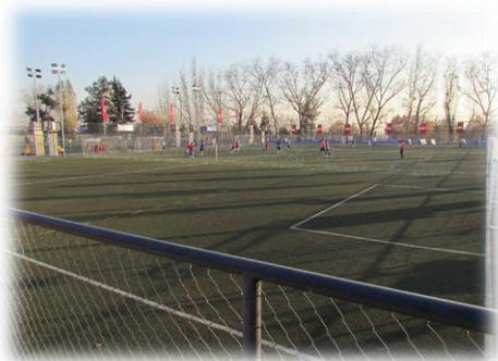
Ilustración 8. Cancha de futbol, protecciones a base de PTR y malla.
