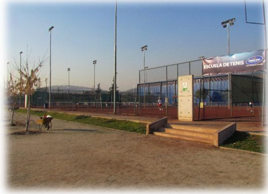
Ilustración 10. Acceso cancha de tenis con protección a base de PTR y malla
