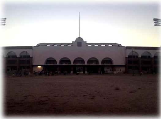
Ilustración 32. Fachada principal, Estadio
