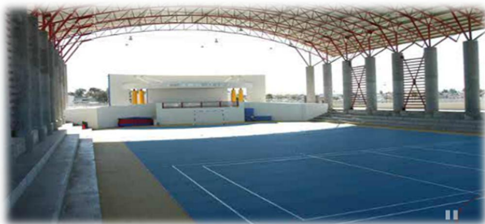
Ilustración 16. Cancha de usos múltiples techada de asfalto
