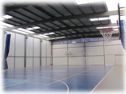
Ilustración 12. Multicancha con estructura de acero
