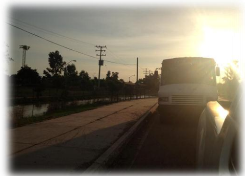
Ilustración 53. Postes de luz, Unidad Deportiva
