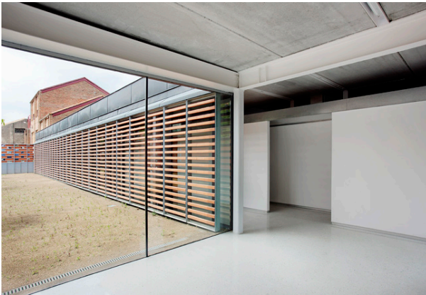
Fotografía 40. Estructura portante [J. Hevia, Actar]. (Cardedeu, 2008).
