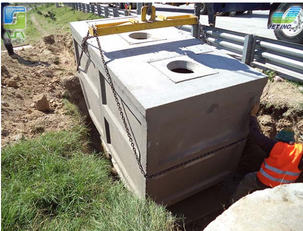
Fotografía 47. Planta tratadora de aguas residuales [Anónimo]. (Guadalajara, 2015).
