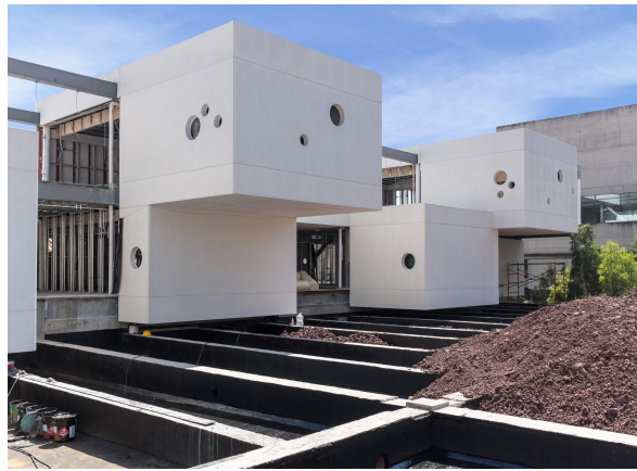
Fotografía 24. Construcción kínder Monte Sinaí [Alfonso Merchand]. (Cd. De México, 2014).
