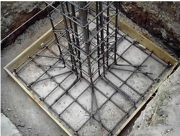
Fotografía 39. Cimentación [Anónimo]. (Aguascalientes, 2008).
