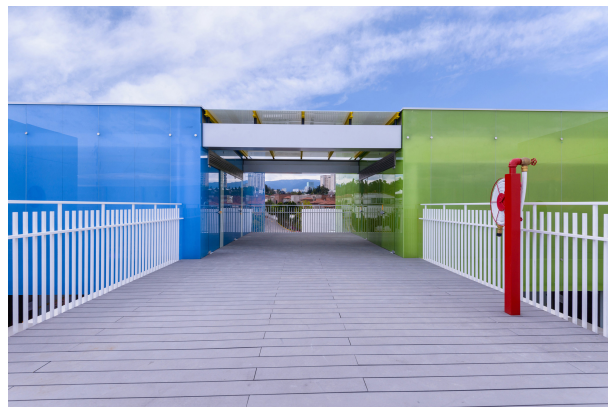
Fotografía 17. Puente kínder Monte Sinaí [Alfonso Merchand]. (Cd. De México, 2014).
