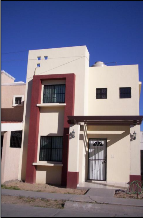
Fig. 5.21 Fachada de la casa Habitación a estudiar.
