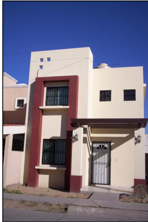
Fig. 4.8 Fotografía de la casa habitación a analizar. Autor: Navarro M. Julio.
