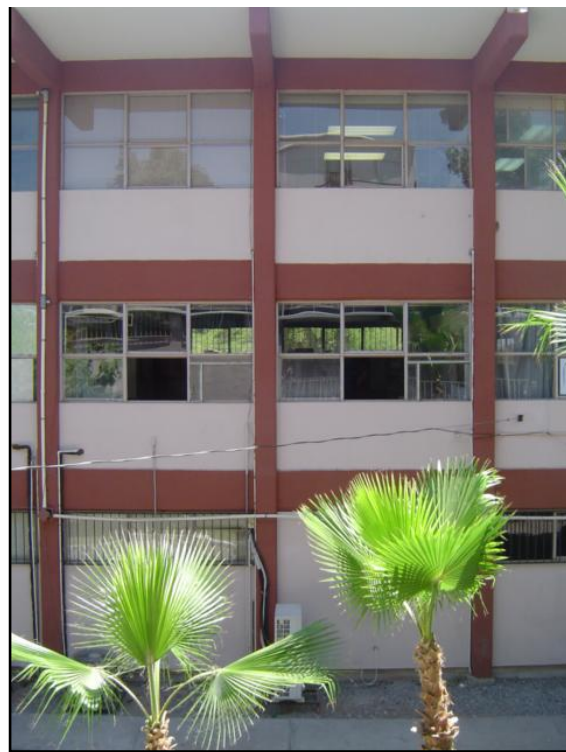
Fig. 4.3 Ventanas situadas al lado norte del aula analizada. Autor: Navarro M. Julio.
