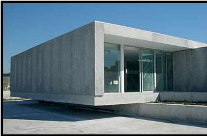
Fig. 2.30 La utilización de materiales aparentes, en éste con el concreto armado, hacen interesante el diseño. Las formas lineales y sencillas que lo conforman, caracterizan su contorno y su fácil percepción.
