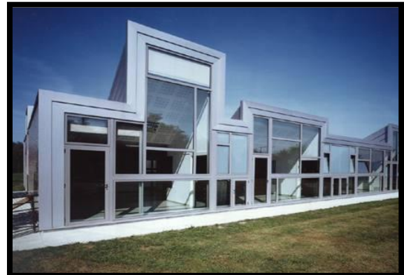
Fig. 2.23 Vista de la guardería infantil, donde el cristal forma parte integral del diseño, utilizado como herramienta de transparencia, iluminación y ventilación. El clima permite una interacción así, pero de ellos se aprende a establecer la interrelación del espacio interior con el exterior.
