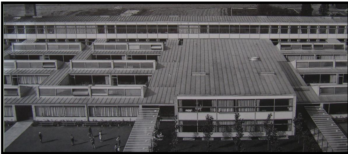
Fig. 2.18 Vista aérea del complejo de la escuela danesa de Munkegards., donde se visualiza de manera radical los ventanales que permiten el paso de iluminación natural a lo largo de todo el edificio, así como los patios interiores que unen las aulas de clase, haciendo de este proyecto único en su categoría.
