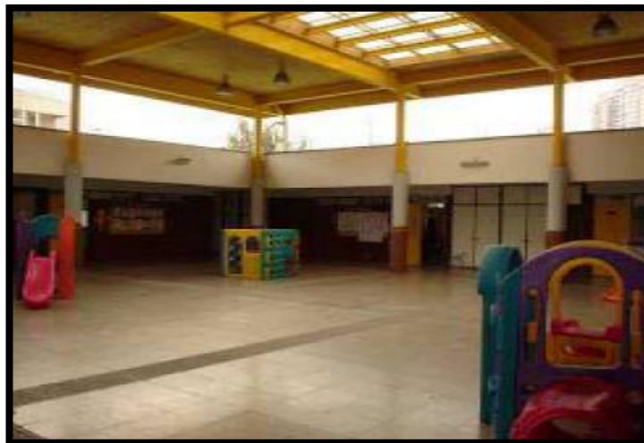
Fig. 4.10 Patio cubierto con entradas de luz que permiten el paso directo de iluminación natural y ventilación. Su cubierta que resguarda todo el jardín interior del mal tiempo y el sol.
