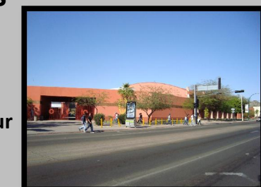
Imagen 4.3: Vista sur Centro de las Artes. Fuente: (Archivo propio)
