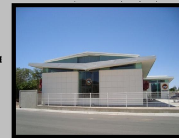
Imagen 4.102: Vista oriente Complejo CTM. Fuente: (Archivo propio)
