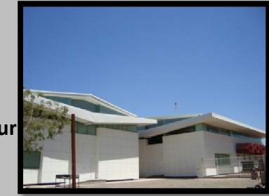
Imagen 4.101: Vista sur Complejo CTM.
