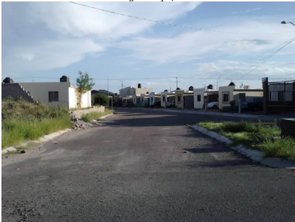
Imagen 8-Vista Sur-Intersección De Calle Vista Alegre Fuente: Fotografía Propia, 2016
