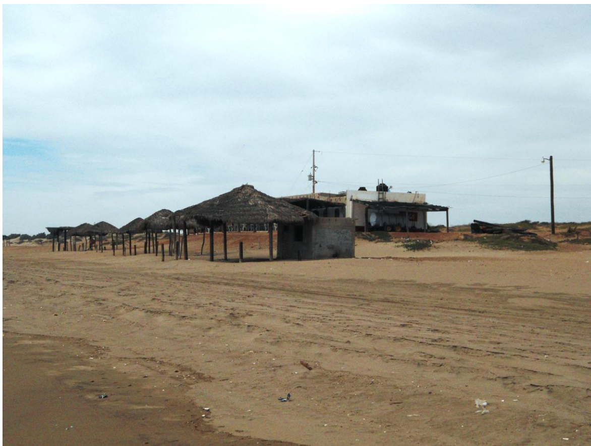
Imagen 2.8 Localización de los postes de iluminación así como del transformador, cercano al terreno seleccionado. Huatabampito, Sonora. Fuente: del autor.
