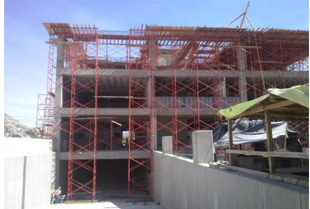
Ilustración 110. Fachada Sur. Avance de construcción en Fachada sur. Autor: Lesley Esquer.
