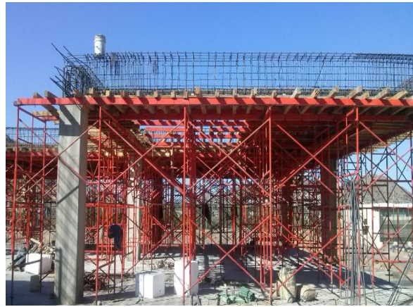
Ilustración 86 Armado de traves del primer nivel. Autor: Eva Zavala.
