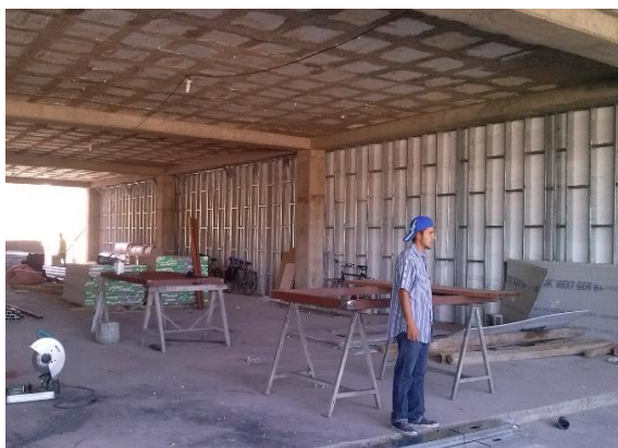
Ilustración 88 Muros perimetrales de durok Autor: Eva Zavala
