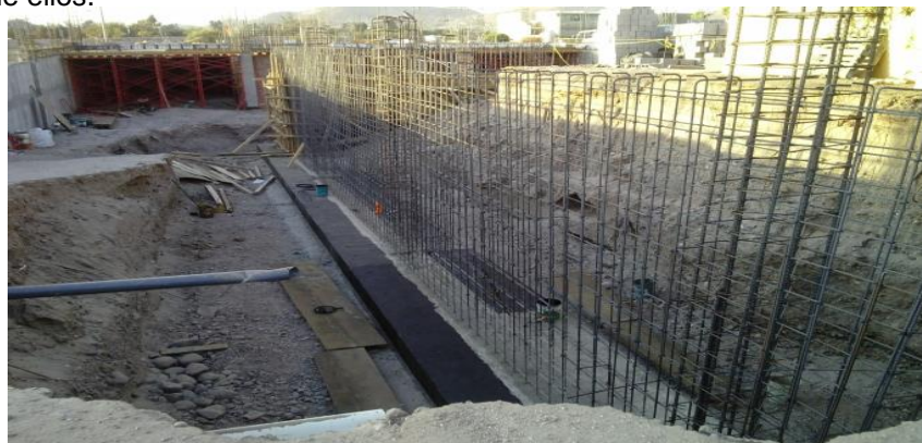
Ilustración 19 Armado de muro de contención en rampa. Autor: Lesley Esquer.
