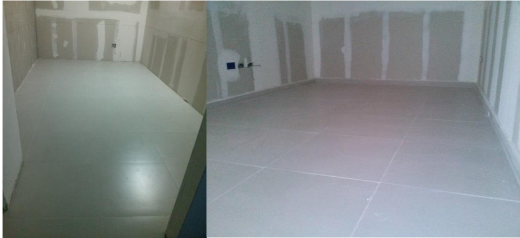
Ilustración 95 Piso porcelánico “Pirineo Blanco” formato 60cm x 60cm con zoclo de 7cm. Autor: Eva Zavala.
