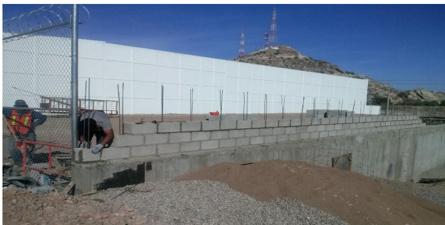
Ilustración 90 Barda de block con castillos ahogados Autor: Eva Zavala
