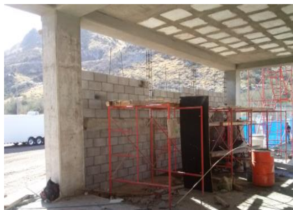
Ilustración 89 Muro perimetral de block de concreto Autor: Eva Zavala.
