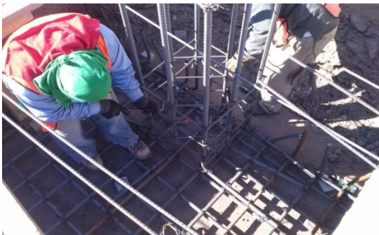
Ilustración 80 Armado de zapata de colindancia Autor: Lesley Esquer.
