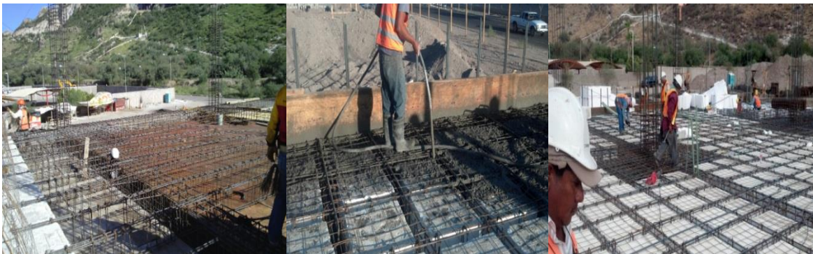
Ilustración 87 Armado y colado de losa del primer nivel. Autor: Eva Zavala
