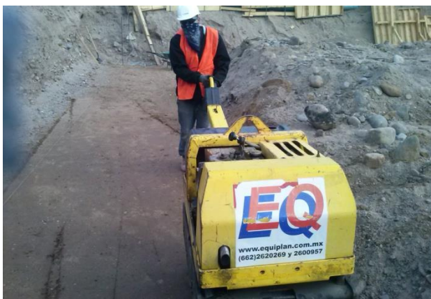
Ilustración 77 Compactación de tierra. Autor: Lesley Esquer.
