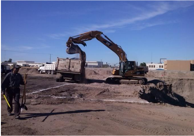
Ilustración 75 Retroexcavadora en predio Autor: Lesley Esquer.
