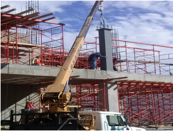
Ilustración 85 Colocación de columna de acero para soporte de ampliación. Autor: Eva Zavala
