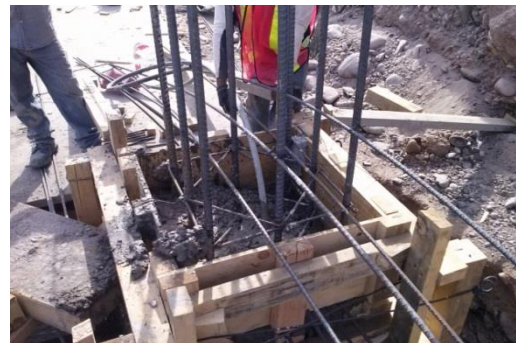
Ilustración 81 Cimbra y colado de dado. Autor: Lesley Esquer.
