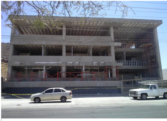
Ilustración 107. Vista de la fachada Norte. Avance en la construcción de la fachada Norte. Autor: Lesley Esquer.
