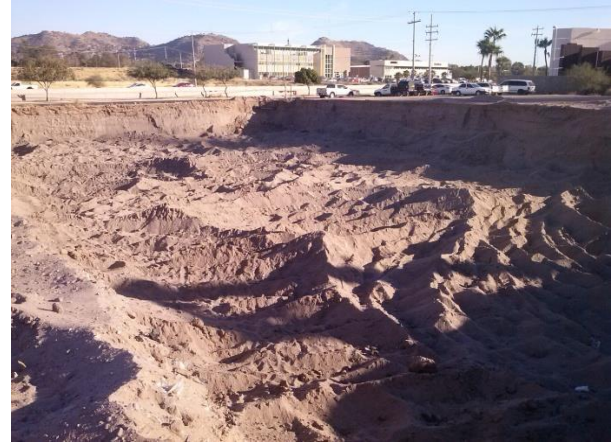
Ilustración 76 Excavación para cimentación. Autor: Lesley Esquer.
