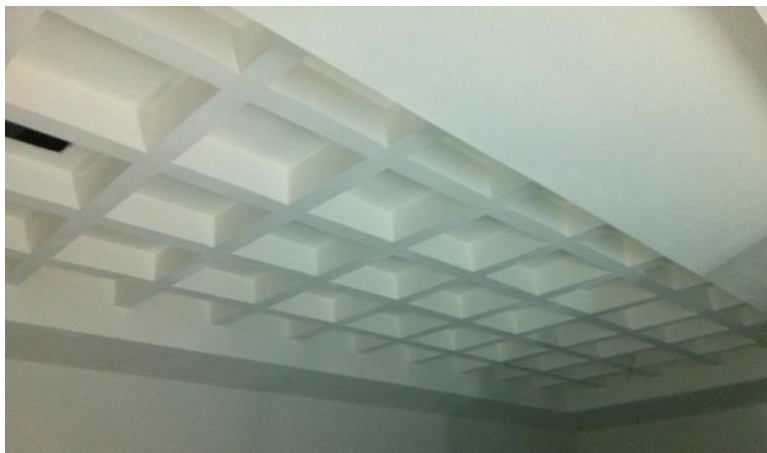
Ilustración 94 Detalle reticular en Sala de Juntas a base de tablaroca. Autor: Eva Zavala
