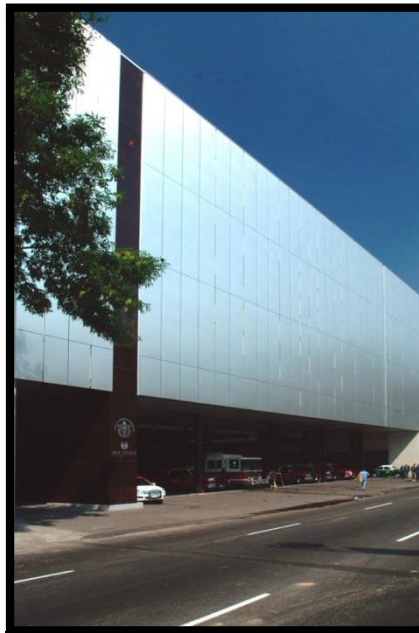
Imagen 0-36- Vista exterior. Estación de Bomberos Ave Fénix. Fuente www.arqdaily.com
