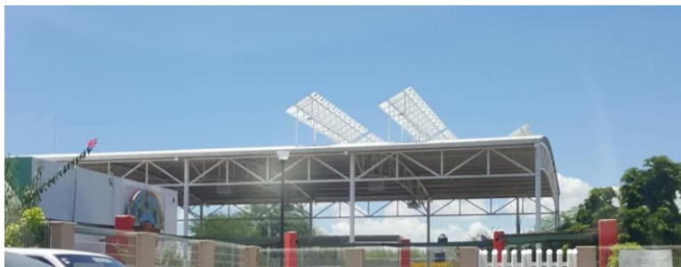
Ilustración 56. Paneles solares en cubierta de estacionamiento. Fuente: Archivo personal de M. García. 01 Diciembre 2016
