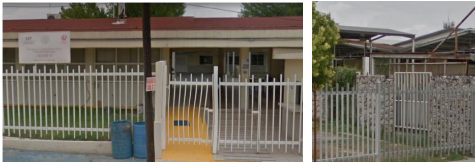
Ilustración 25 y 26. Entradas del edificio. Fuente: Google Maps. Enero 2018
