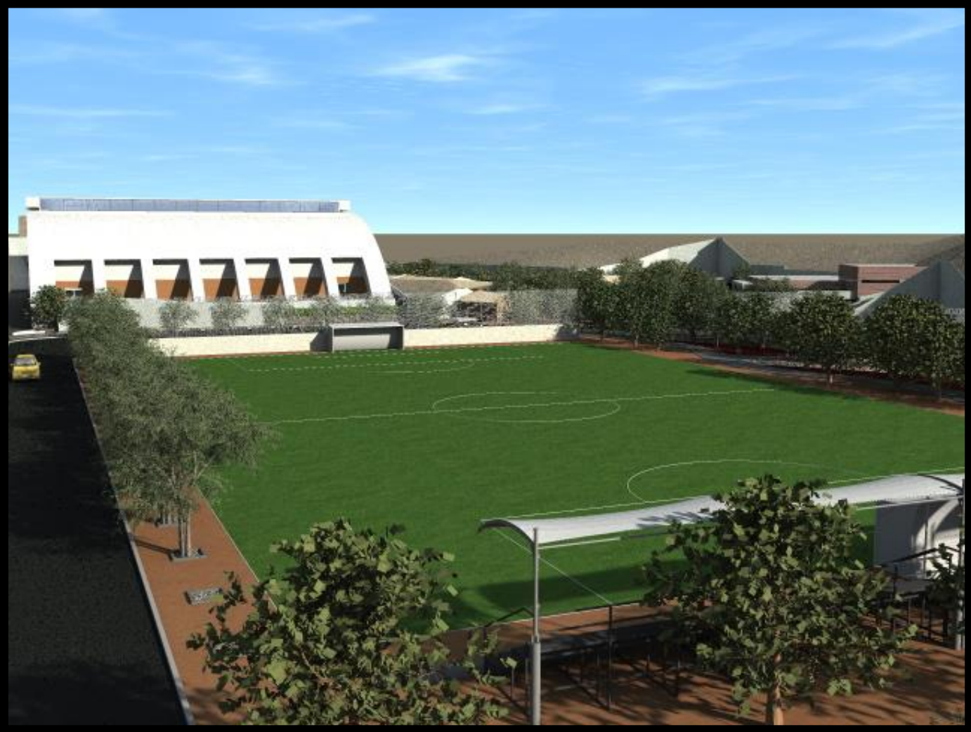
Vista aérea cancha futbol soccer. Al fondo gimnasio polivalente.
