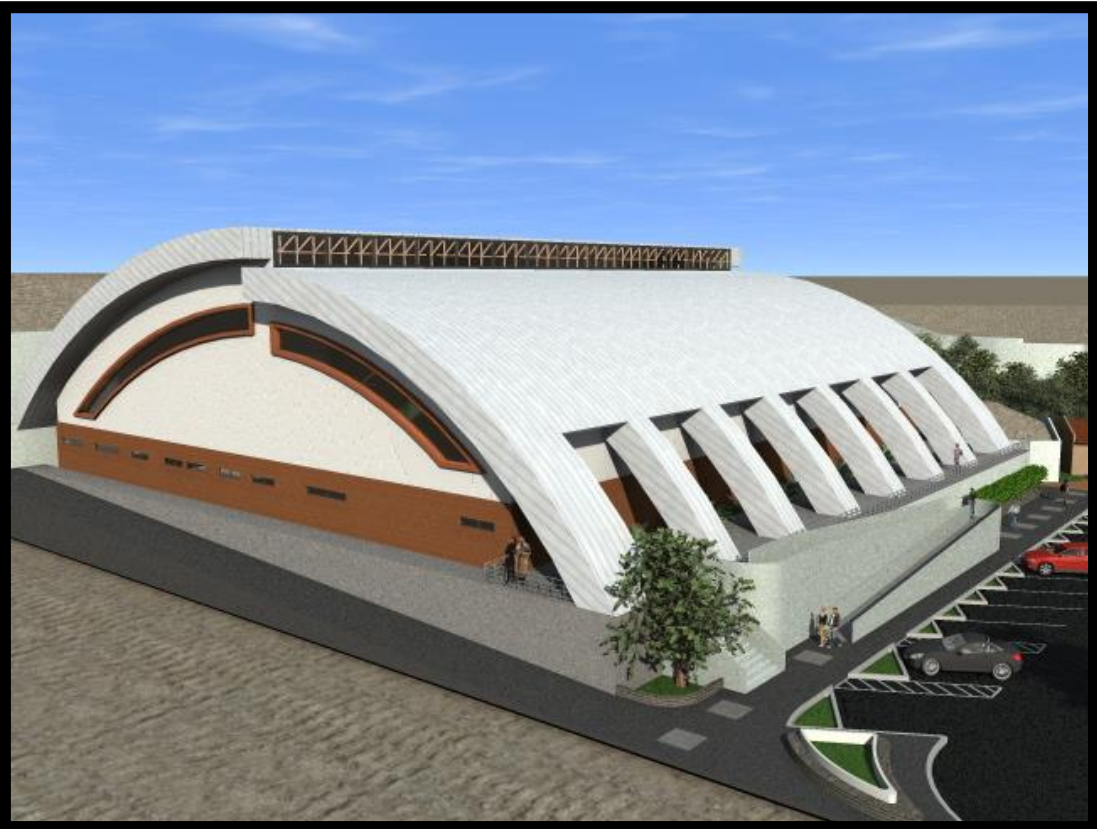
Vista aérea de Gimnasio Polivalente, lado oeste.
