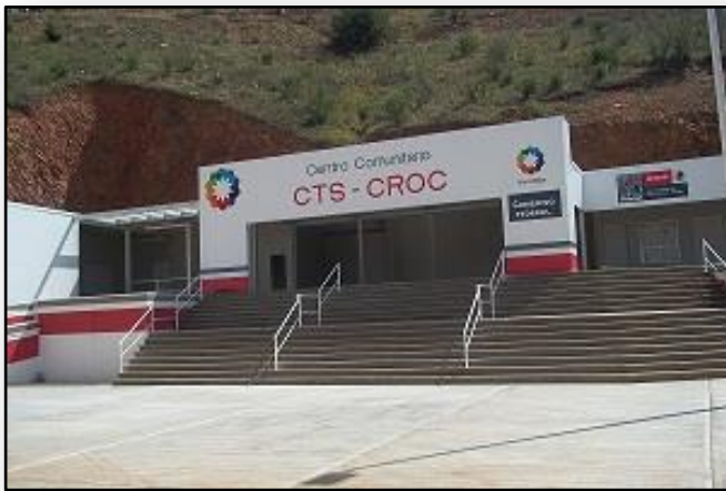
Imagen 1.5 Fachada Principal Centro CTS-CROC.
