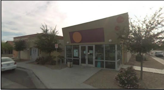
Imagen 1.23 Fachada Principal de Centro de Desarrollo Comunitario Fuente: http://www.glendaleaz.com/EnEspanol/Centro_de_la_Comunidad_de_Glendale.cfm.html
