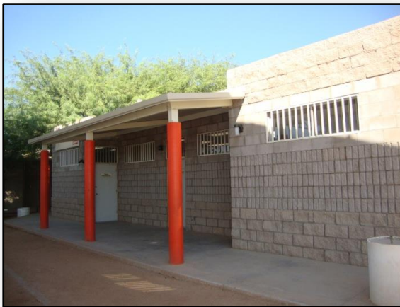
Imagen 1.10 Centro de computo, Sala Audiovisual y Presencial. Fuente: Archivo propio. S/E
