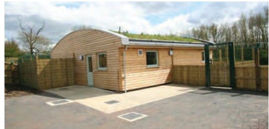
Foto 2.35. Vista del edificio Santuario 2. Fuente: http://www.napierandco.com
