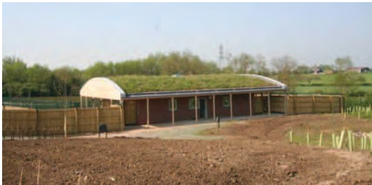
Foto 2.34. Vista del edificio Santuario. Fuente: http://www.napierandco.com
