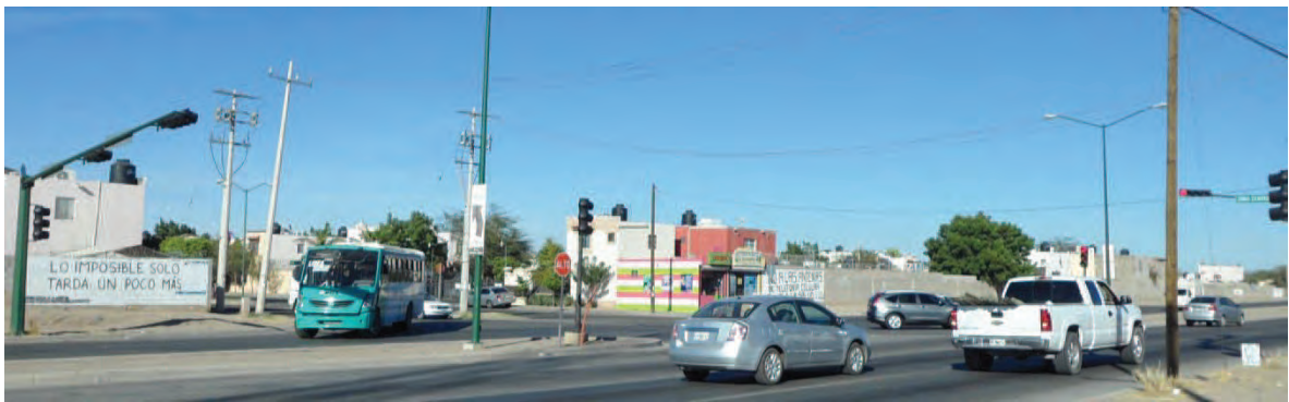
Foto 2.6. Nodo creado en la intersección del Bulevar Camino de Seri y Quintero Arce. Fuente A.C.
