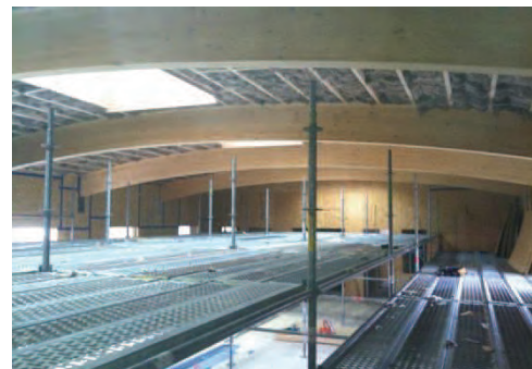
Foto 2.43. Utilización de vigas de madera. Fuente: http://www.napierandco.com
