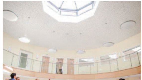
Foto 2.21. Traga luz para mayor iluminación en recepción. Fuente: http://www.mcphillips.co.uk
