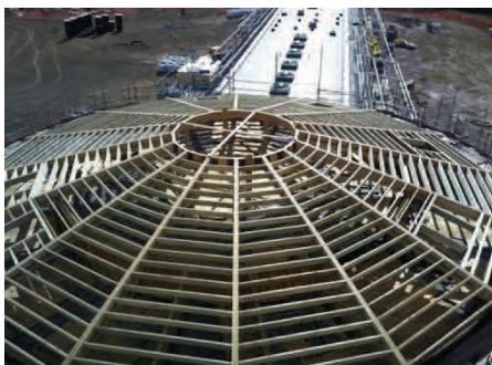
Foto 2.42. Armado de madera en techumbre. Fuente: http://www.napierandco.com
