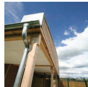
Foto 2.38. Captadores de agua pluviales. Fuente: http://www.napierandco.com
