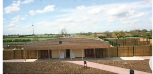
Foto 2.33. Vista del edificio de Admisión. Fuente: http://www.napierandco.com
