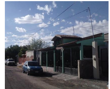
Ilustración 31. Colindancia oeste. Vista desde la calle Ignacio Hernández. Fuente propia
