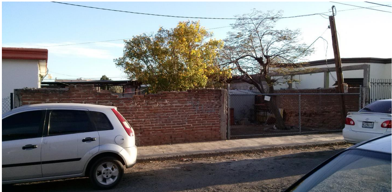
Ilustración 27. Fotografía del estado actual de la colonia Balderrama. Fuente propia.
