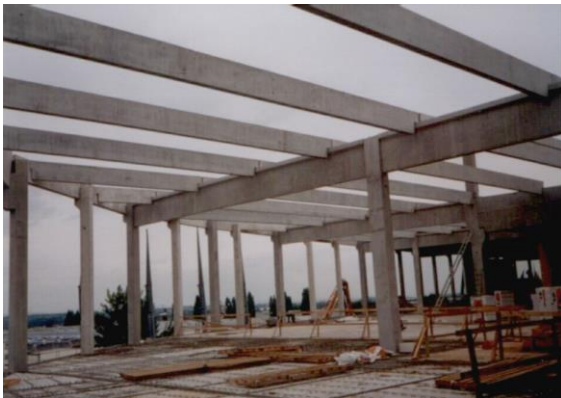
Ilustración 90. Imagen de referencia. Uso del acero como estructura portable. Fuente: http://www.archdaily.mx/mx
