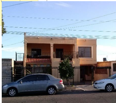
Ilustración 30. Colindancia norte. Vista desde la calle Leocadio Salcedo. Fuente propia
