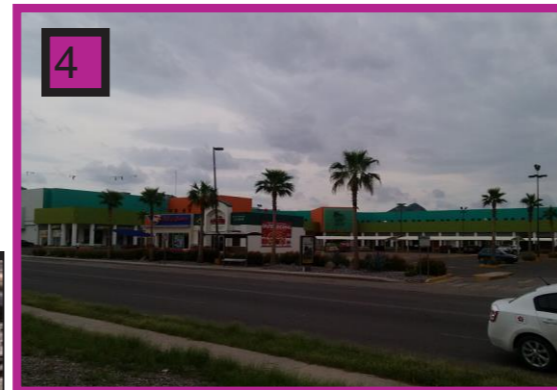
Imagen 2.18 Pabellón Reforma. Fuente Archivo Propio
