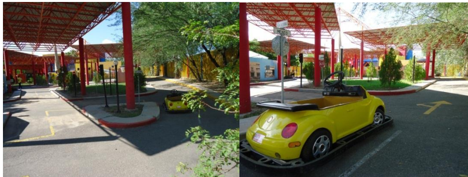
Foto 30. Vistas del sistema constructivo. Aquí se alcanzan a notar las columnas, armaduras y láminas empleadas en la construcción de los elementos de sombra. Archivo fotográfico propio 2012
