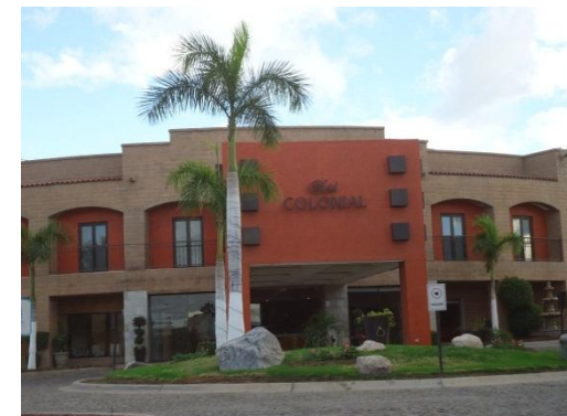
Foto 11. Hotel Colonial. Vista de la fachada principal de acceso a los usuarios de la cadena hotelera. Archivo fotográfico propio (2012)
