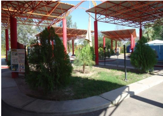
Foto 23. Techumbres del Parque Vial. Archivo fotográfico propio 2012
