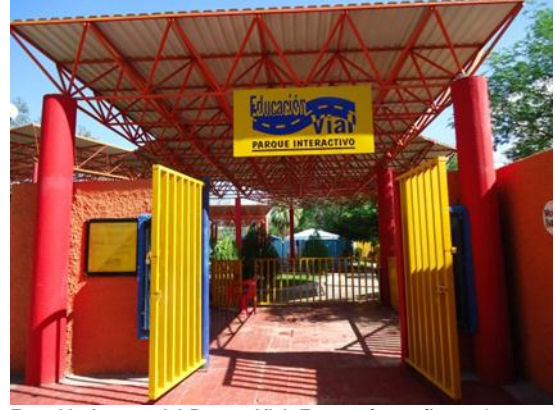
Foto 29. Acceso del Parque Vial. En esta fotografía se alcanza a notas la lámina acanalada, además de las armaduras utilizadas. Archivo fotográfico propio 2012
