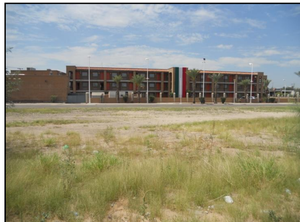
Imagen 16. Hotel Colonial. Vista hacia el poniente desde el predio. Fuente: Elaboración propia.
