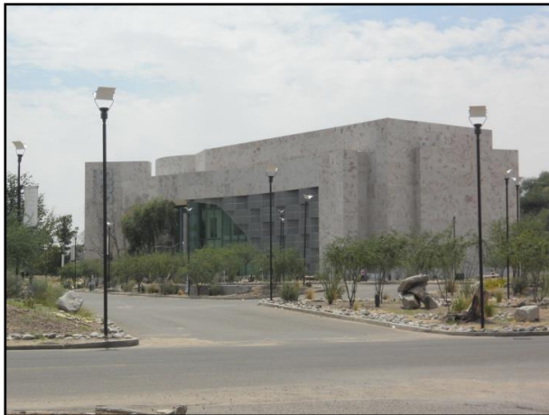
Imagen 13. Centro Cultural Musas. Vista hacia el sur desde el predio. Fuente: Elaboración propia.
