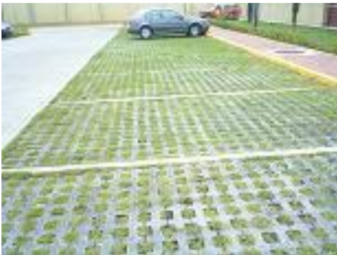
Imagen 38. Adopasto. Vista de la cuadrícula que forma este sistema en estacionamientos. Fuente: www.archiexpo.es
